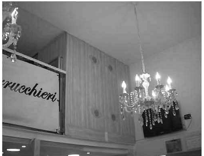
(foto 4: vista soppalco)
