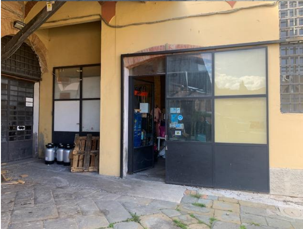
Vista ingresso sub 11 da corte interna
