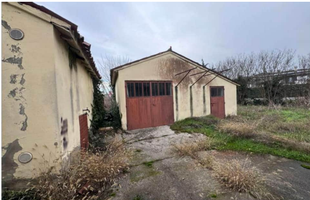
FOTO 3 - Fronte sud dei sub. 1 e 2
