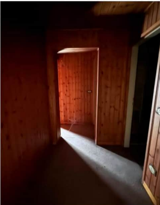
FOTO 7 - Disimpegno Piano primo sub. 1
