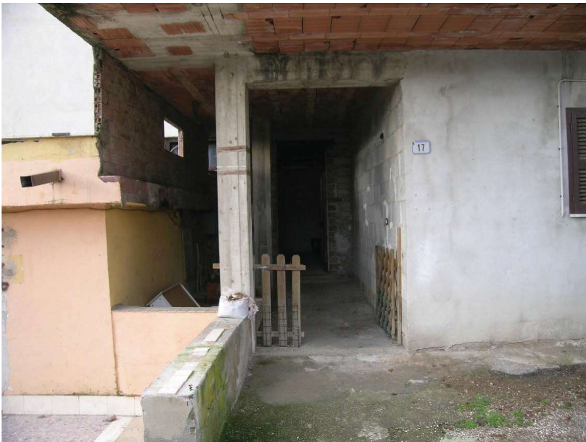
FOTO INGRESSO ALLE SCALE N.C. 17
