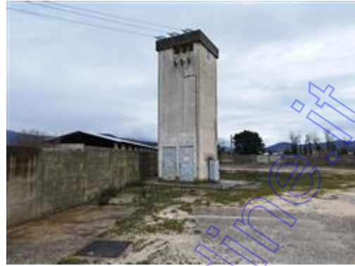
Prospetto cabina elettrica sub. 14
