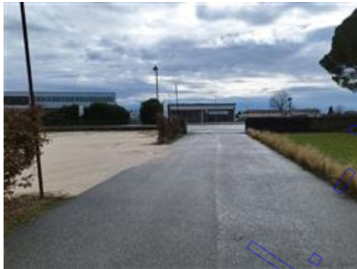
Area esterna, viabilità interna
