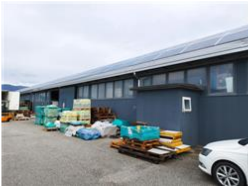
Prospetto ovest con vista impianto fotovoltaico
