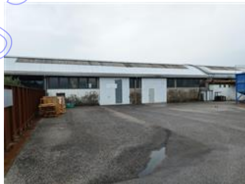
Prospetto est sub. 5
