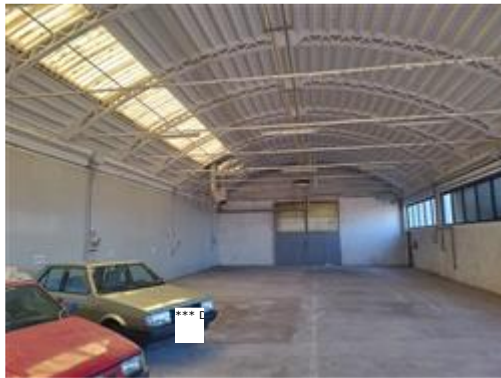
Particolare interni magazzino
