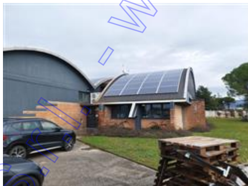
Prospetto ovest con vista impianto fotovoltaico
