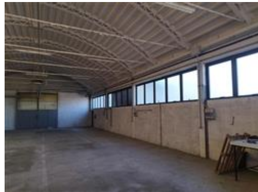
Particolare interni magazzino
