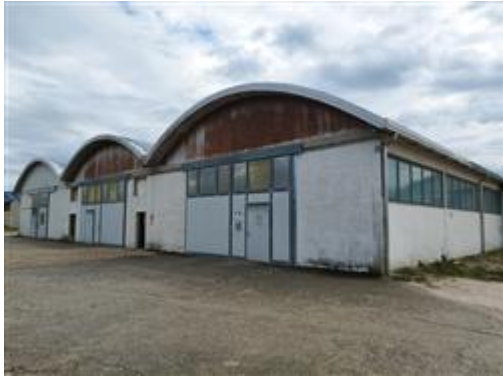
Prospetto nord sub. 7 e limitrofi sub. 6 e pc 1082 sub. 4
