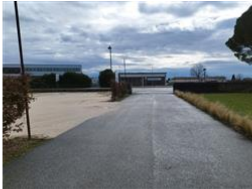
Area esterna, viabilità interna
