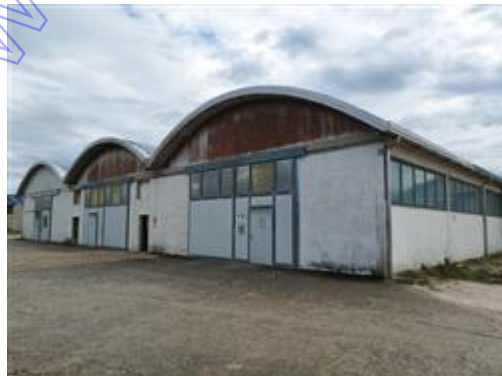
Prospetto nord pc. 1082 sub. 4 e limitrofi subb. 6 e 7 della pc. 255
