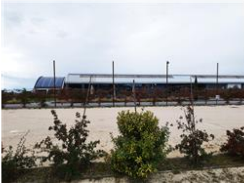
Area esterna con vista impianto fotovoltaico
