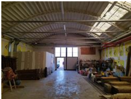
Particolare interni magazzino con vista ripostiglio
