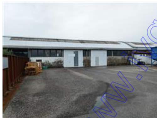
Prospetto est sub. 20 e limitrofo sub. 5
