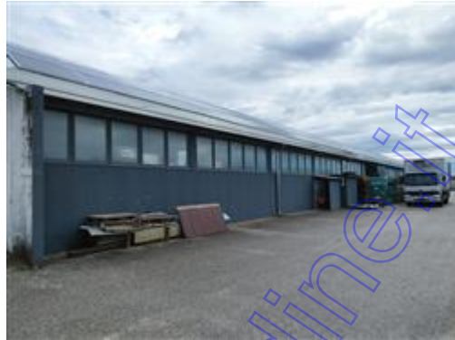
Prospetto ovest con vista impianto fotovoltaico
