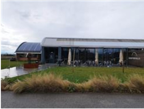
Prospetto est sub. 21
