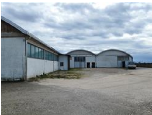
Prospetto nord pc. 1083 sub. 4 e limitrofi subb. 7 e 8 della pc. 255
