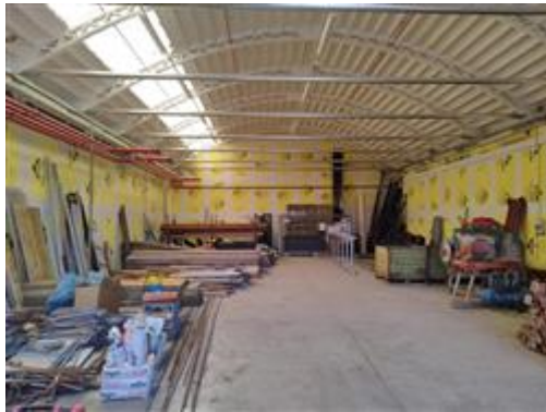
Particolare interni magazzino
