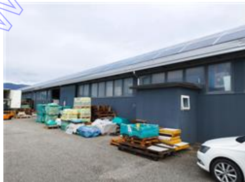
Prospetto ovest sub. 19 e limitrofo sub. 21
