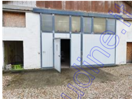
Particolare esterni lato nord
