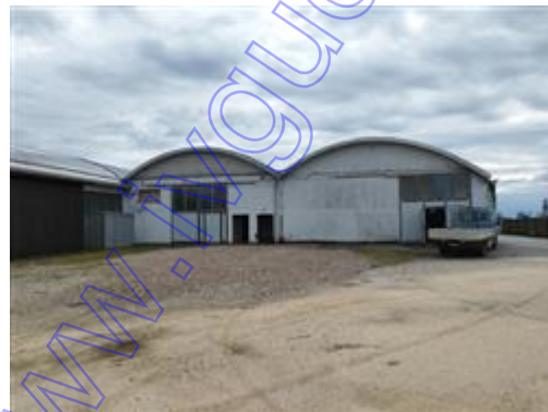
Prospetto nord pc. 1083 sub. 4 e limitrofo sub. 8 della pc. 255
