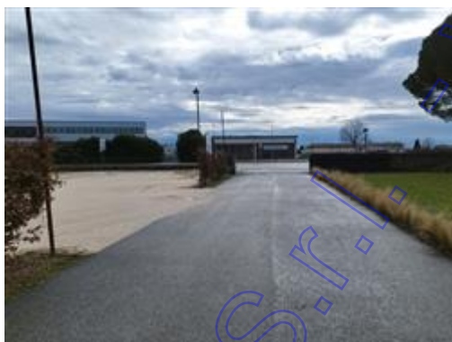
Area esterna, viabilità interna
