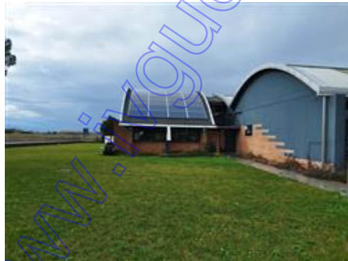
Prospetto sud con vista impianto fotovoltaico
