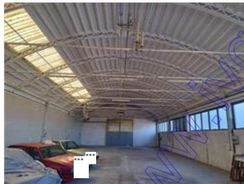
Particolare interni magazzino
