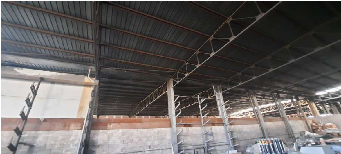
Vista interna – particolare della copertura e della struttura portante
