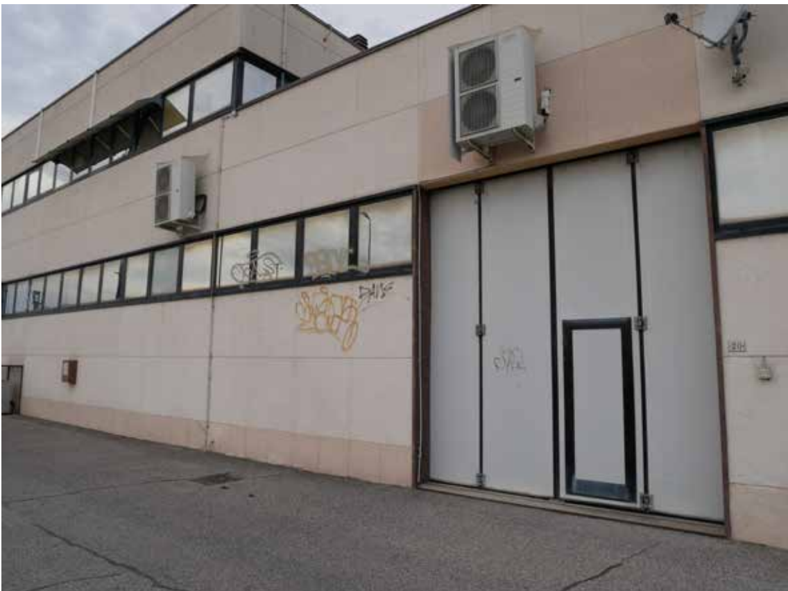
foto 04 - vista esterna negozio
