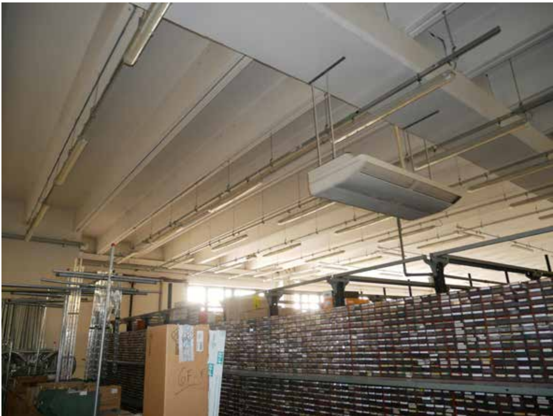
foto 09 - vista interna negozio
