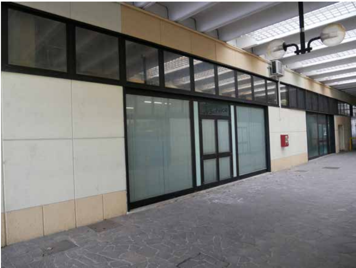
foto 01 - vista esterna negozio
