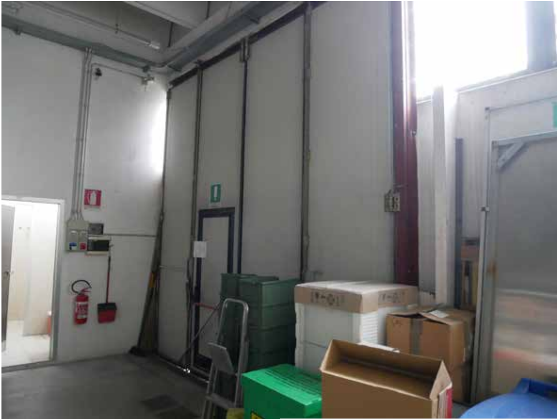
foto 13 - vista interna negozio
