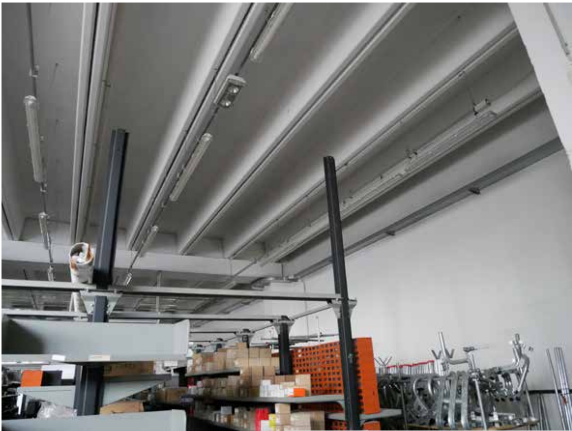
foto 15 - vista interna negozio
