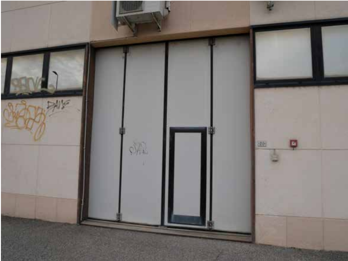
foto 03 - vista esterna negozio
