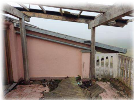
Terrazzino privo di copertura
