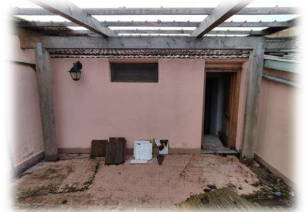
Terrazzino privo di copertura
