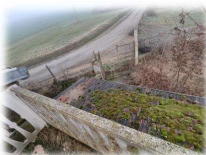
Vista dal terrazzino sulla copertura del portico verandato sottostante
