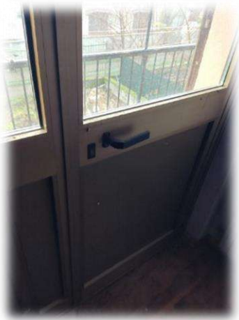
Serramento su balcone
