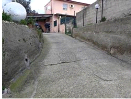
strada di collegamento di proprietà tra il cancello e l'edificio
