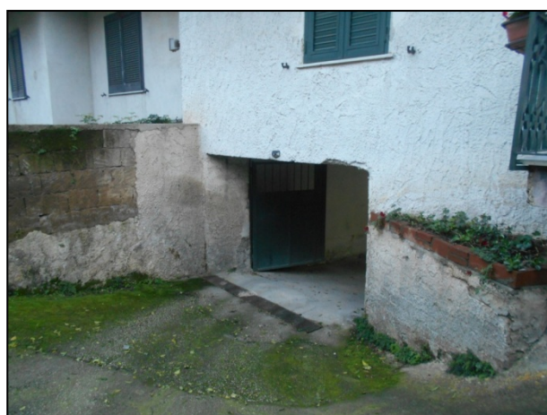
FOTO 28 - ACCESSO AL DEPOSITO
