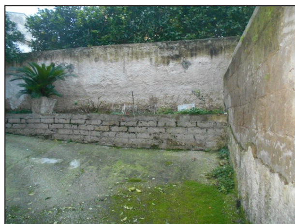
FOTO 34 - RAMPA ACCESSO DEPOSITO
