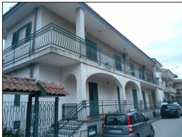
FOTO 2 – PROSPETTO DA VIA FILIPPO TURATI
