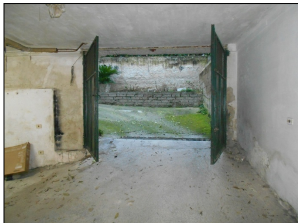
FOTO 32 - ACCESSO CARRABILE DEPOSITO
