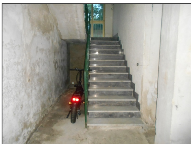
FOTO 33 - SCALA COMUNE - P. SEMINTERRATO
