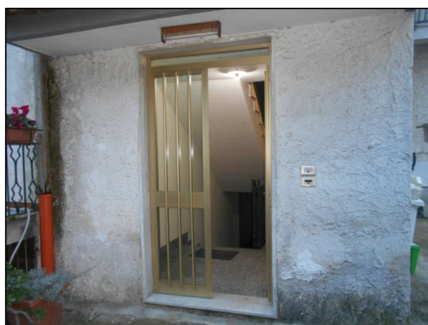
FOTO 4 – ACCESSO VANO SCALA COMUNE
