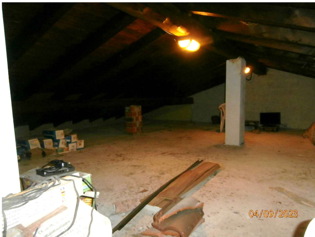
Vista interna sottotetto accessibile e non abitabile
