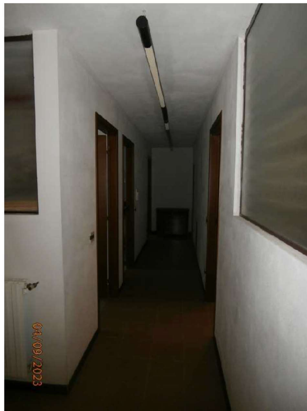
Vista interna disimpegno 2 a piano interrato
