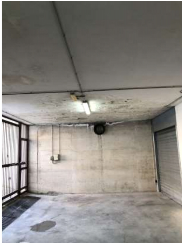
Foto 17: corsia di manovra autorimessa
