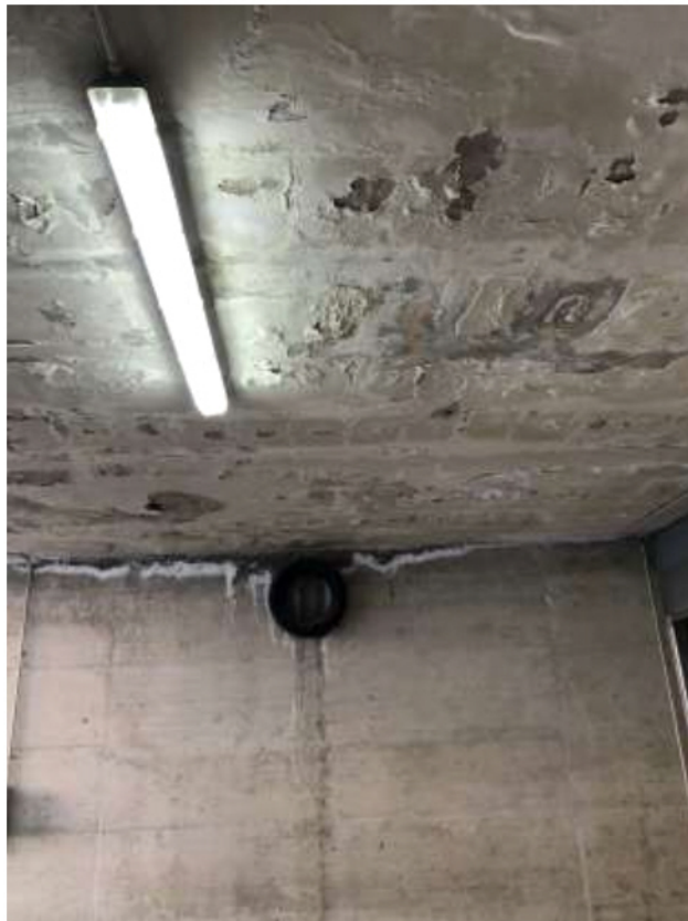
Foto 18: particolare infiltrazioni)
