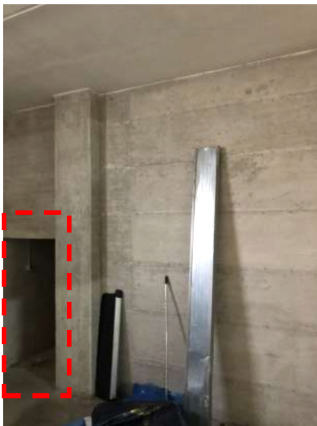
Foto 20: interno box auto (si nota l'apertura al piccolo locale sottorampa)
