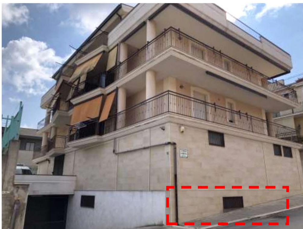
Foto 2: vista ingresso box auto da condominiale da via Bradano n. 13
