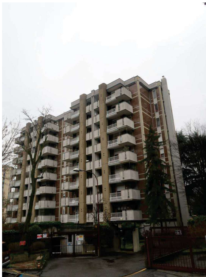
FACCIATA SU INGRESSO
