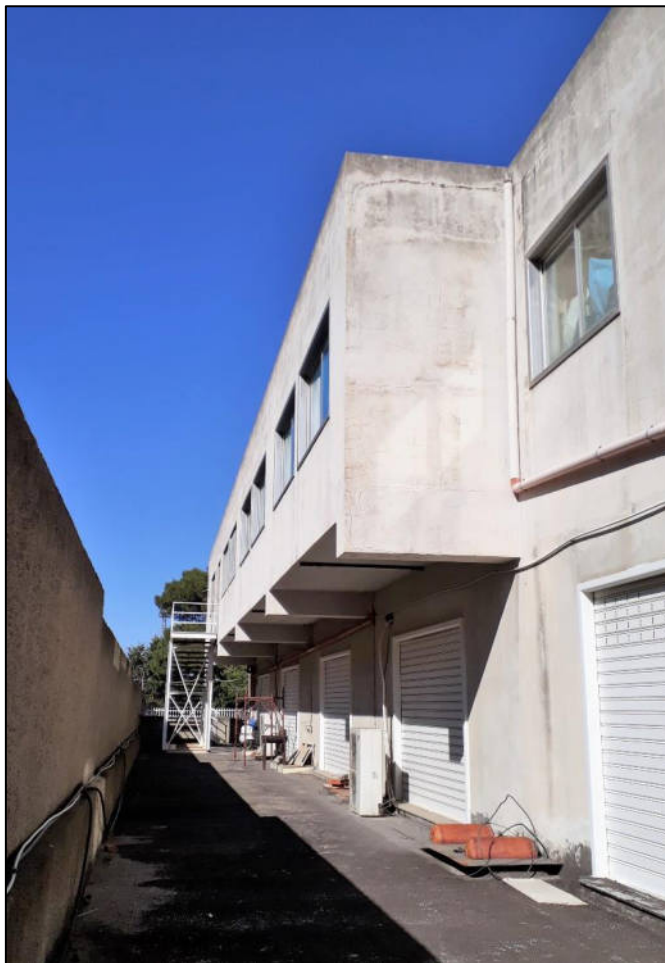
FOTO 08: corte esclusiva lato ovest.
