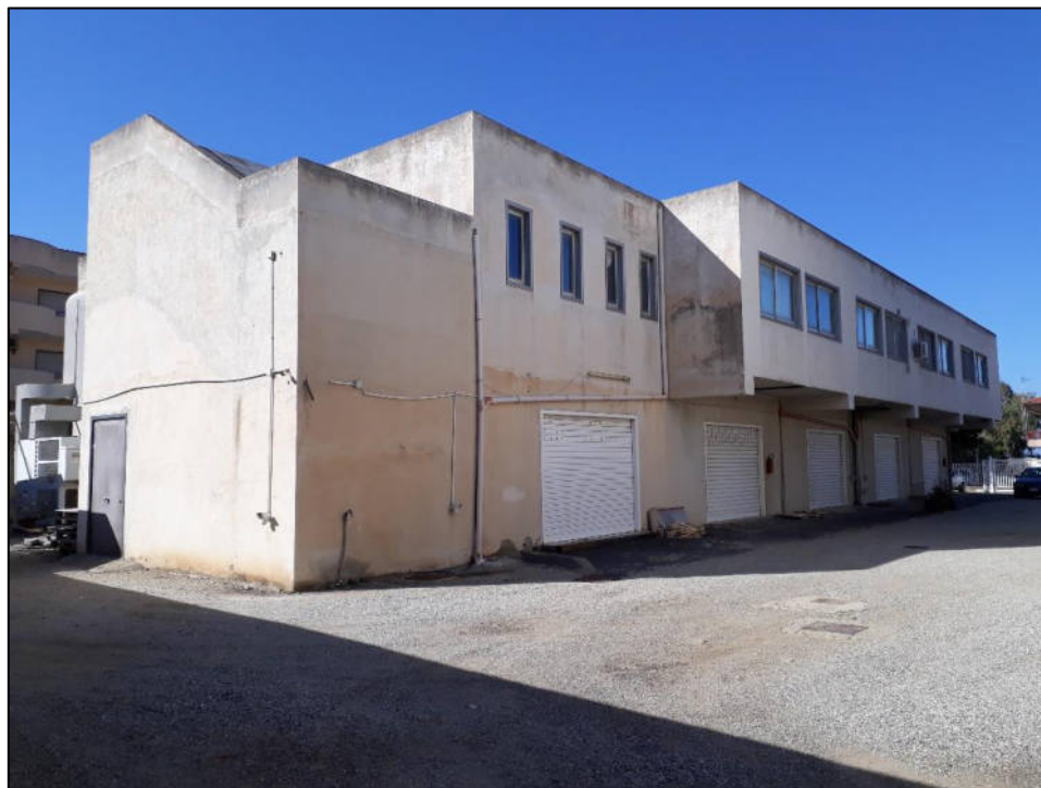
FOTO 06: vista edificio angolo sud-est.
