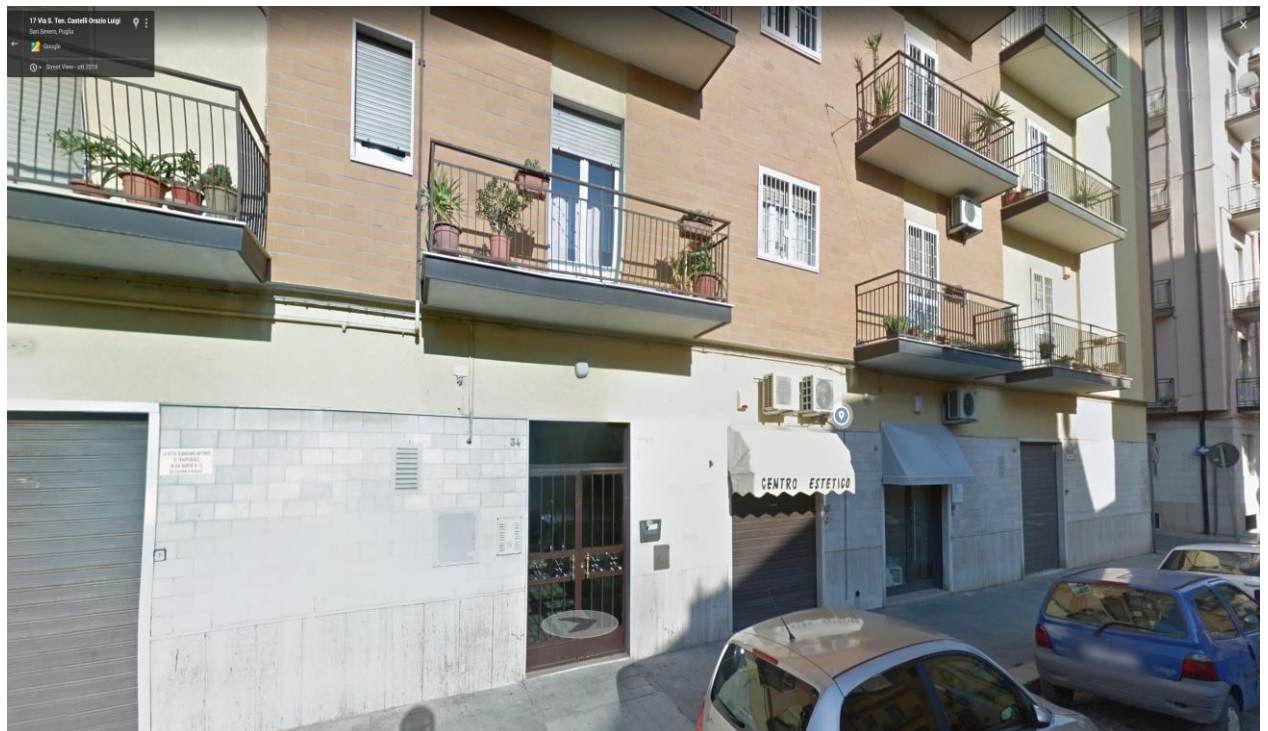
Figura 4: ubicazione immobile, via S. Ten. Castelli Orazio Luigi, 34 - San Severo (FG) (41.687558, 15.383845)
