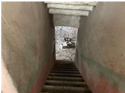
scala interna in pietra
