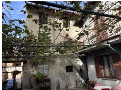
facciata sud dalla proprietà confinante
