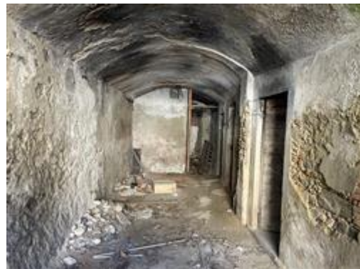
ingresso al fabbricato al piano terreno
