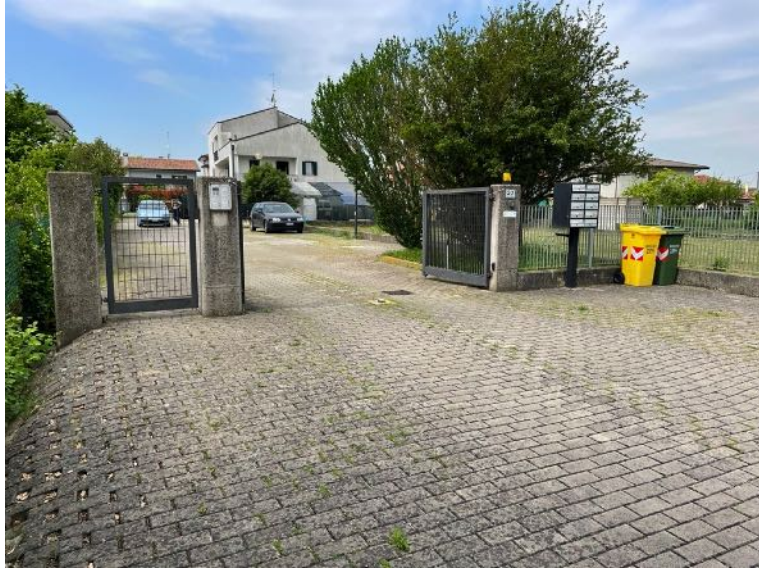
Ingresso all'area scoperta comune e prospetto Est dell'edificio
