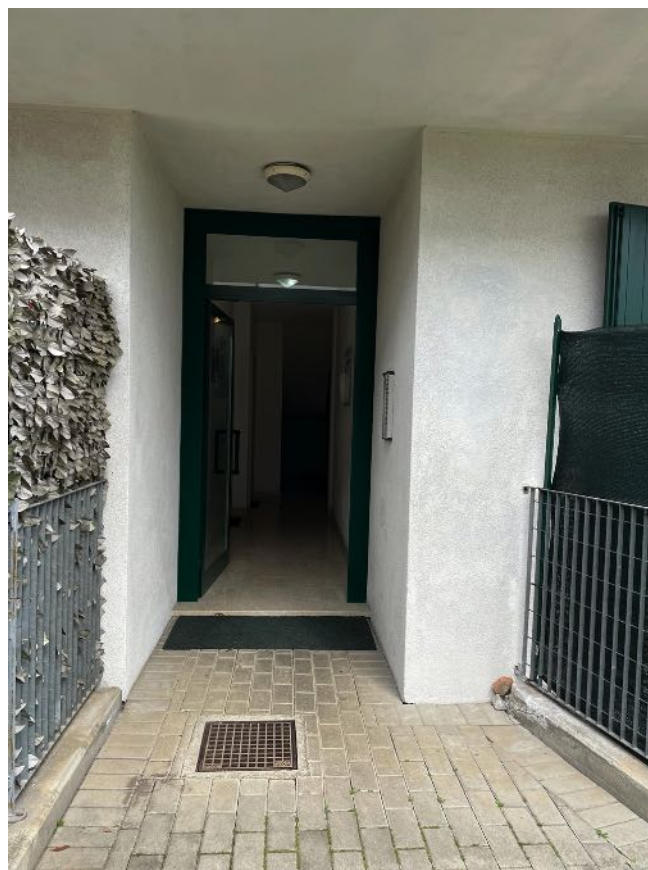
Ingresso comune (piano terra)
