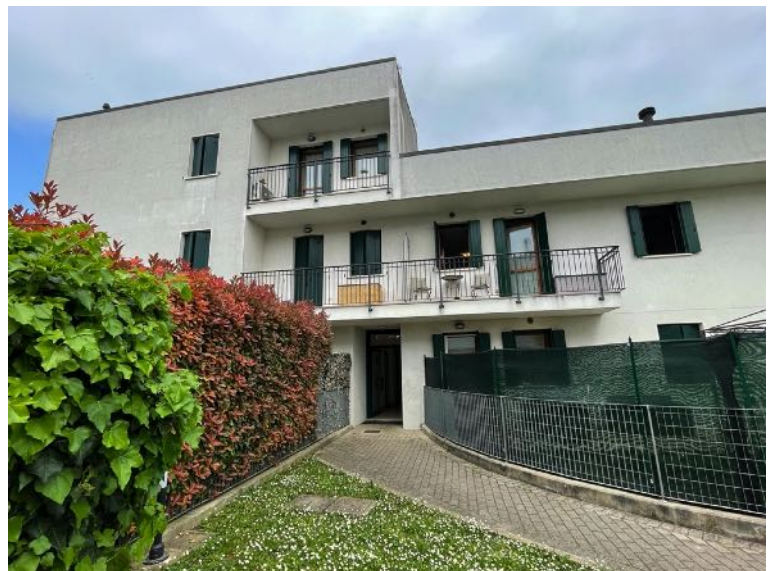
Prospetto Sud dell'edificio (ingresso comune)
