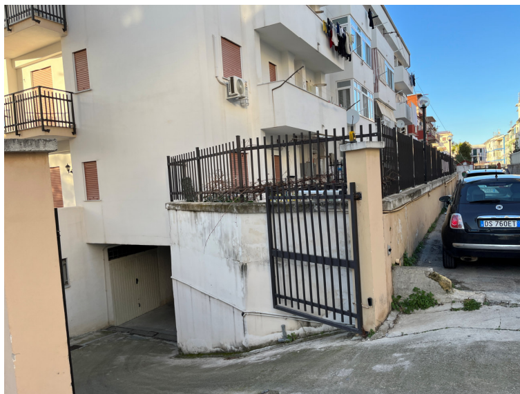
Foto 18 Ingresso carrabile scantinato
