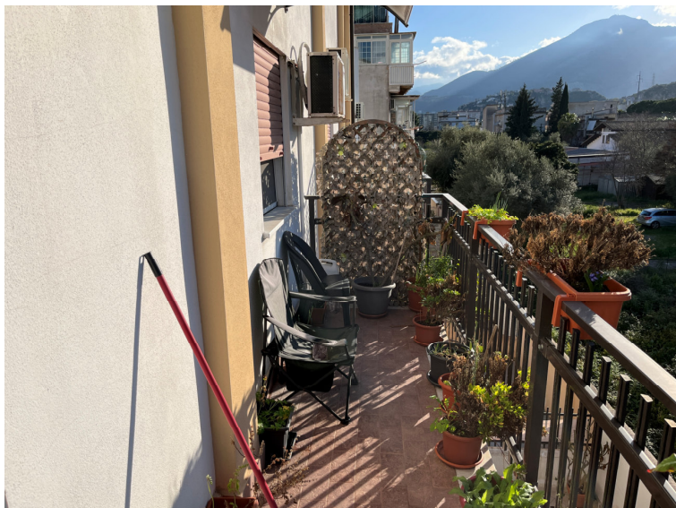
Foto 16 - balcone su cortile interno -
