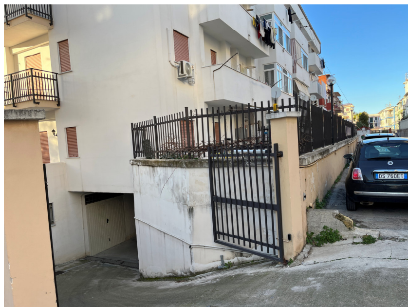
Foto 18 Ingresso carrabile scantinato
