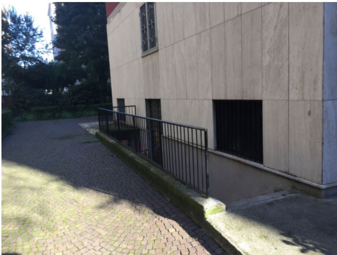
Foto 04 - Ingresso all'unità dalla scala esterna sul cortile condominiale
