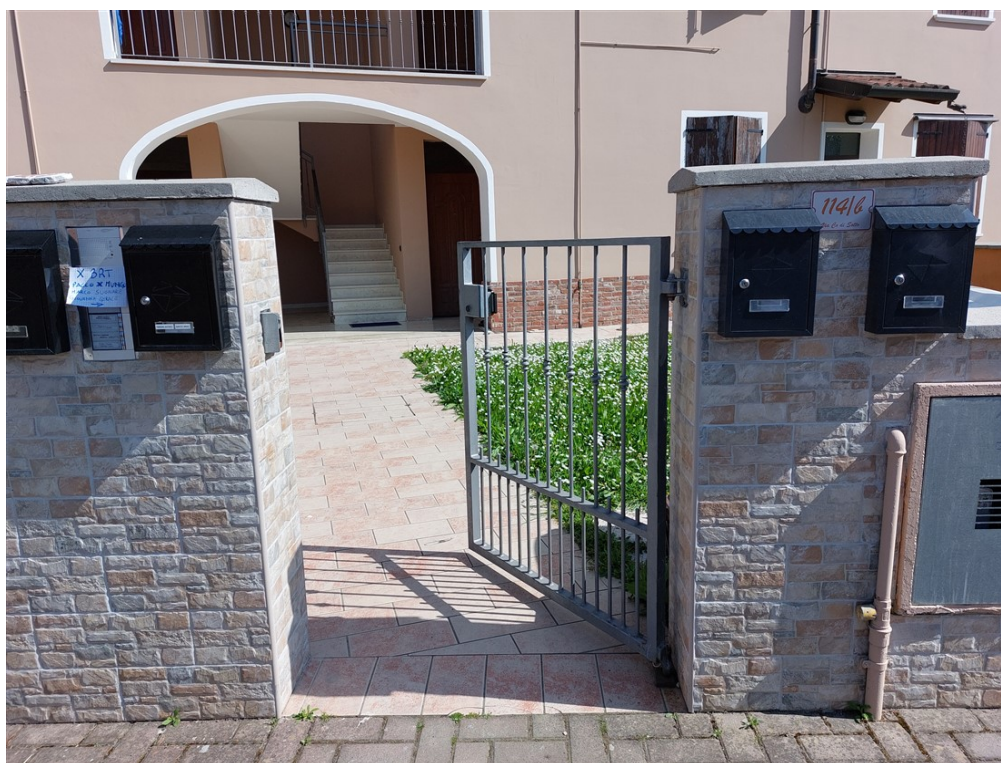
FOTO 2 – VISTA ESTERNA – INGRESSO COMUNE
