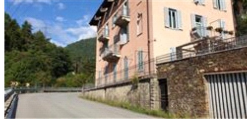
Fronte sud visto da sud-est
