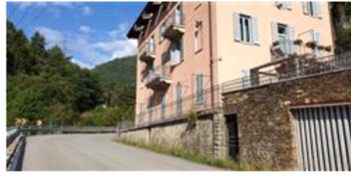
Fronte sud visto da sud-est
