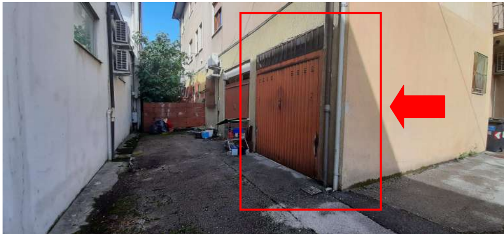
Figura 18 prospetto SUD autorimessa al piano terra
