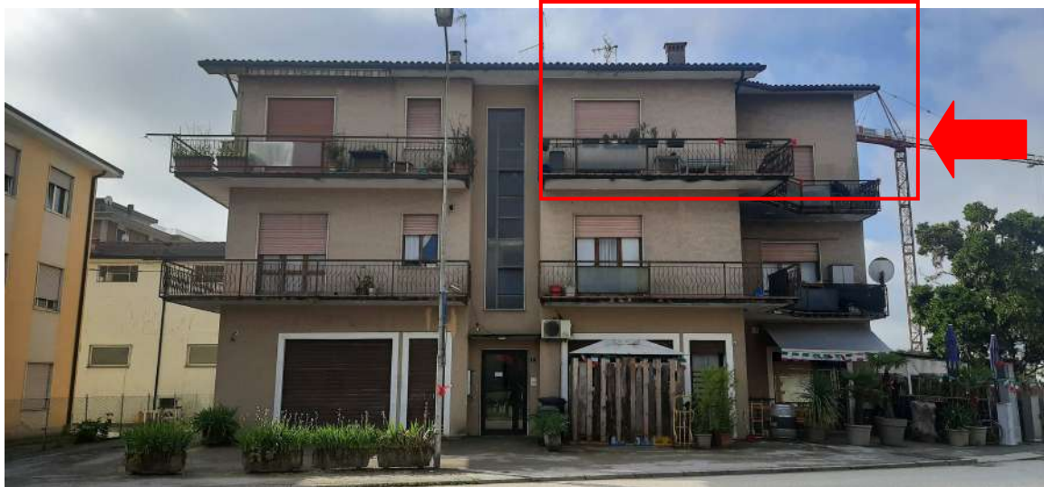
Figura 6 prospetto NORD appartamento al piano secondo
