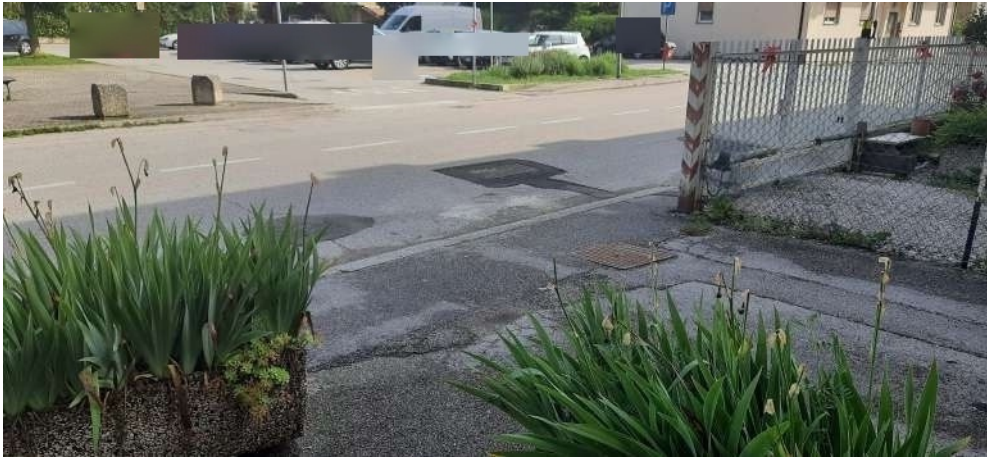
Figura 15 accesso carraio da via Filzi
