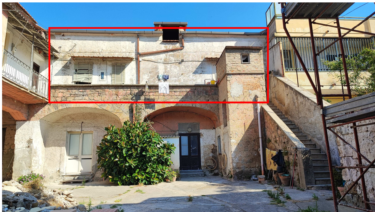
Prospetto del fabbricato
