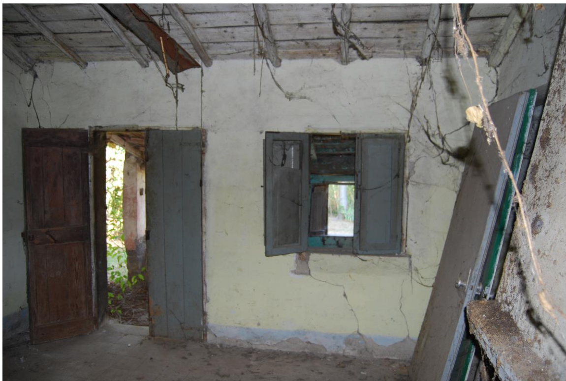
Foto n. 10 – Vista interna (cucina)
