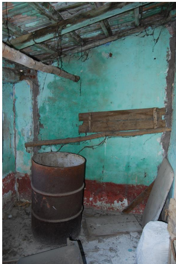
Foto n. 12 – Vista interna (ripostiglio)
