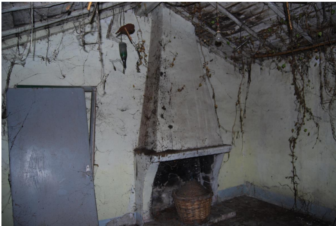
Foto n. 9 – Vista interna (cucina)
