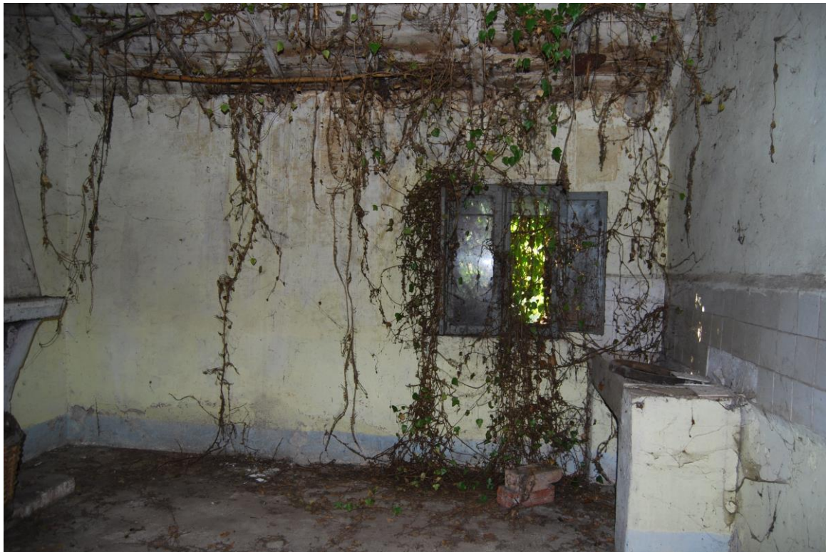
Foto n. 8 – Vista interna (cucina)
