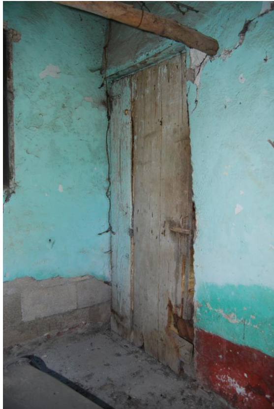
Foto n. 15 – Vista interna (ripostiglio)
