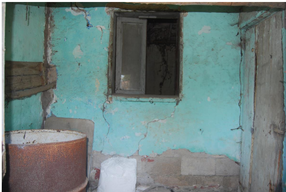
Foto n. 14 – Vista interna (ripostiglio)
