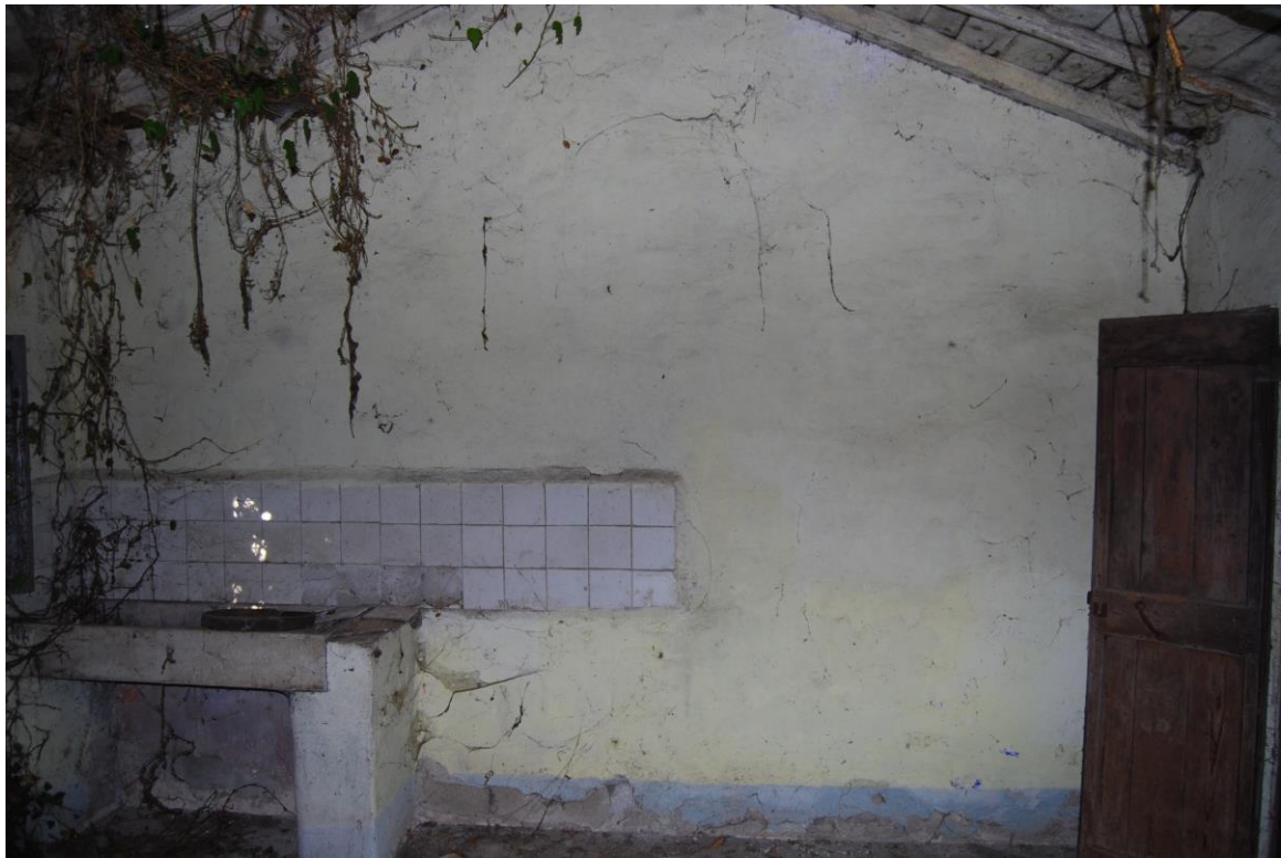
Foto n. 11 – Vista interna (cucina)
