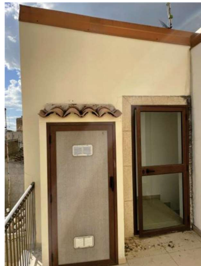
Terrazza - Piano Quarto
