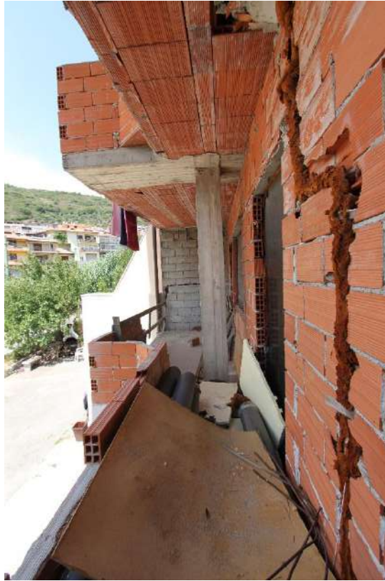
Figura 74- vista 71, balcone frontale piano terra
