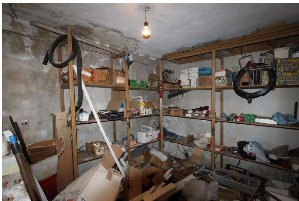
Figura 16- vista 12, loc. deposito
