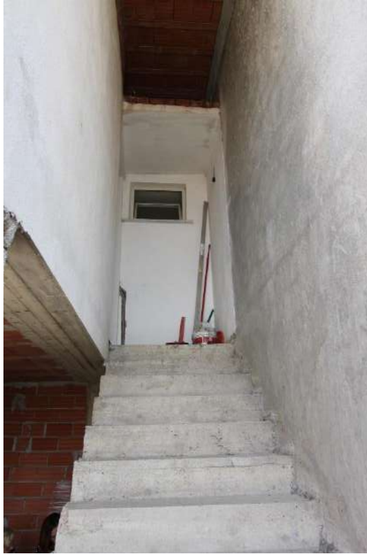
Figura 76- vista 73, scale esterne di accesso al piano primo
