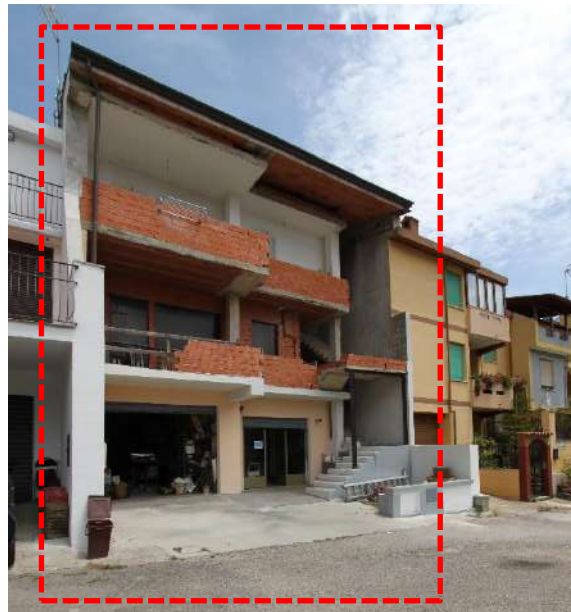
Figura 40- vista 36, Fabbricato dalla Via P.P.Siotto
