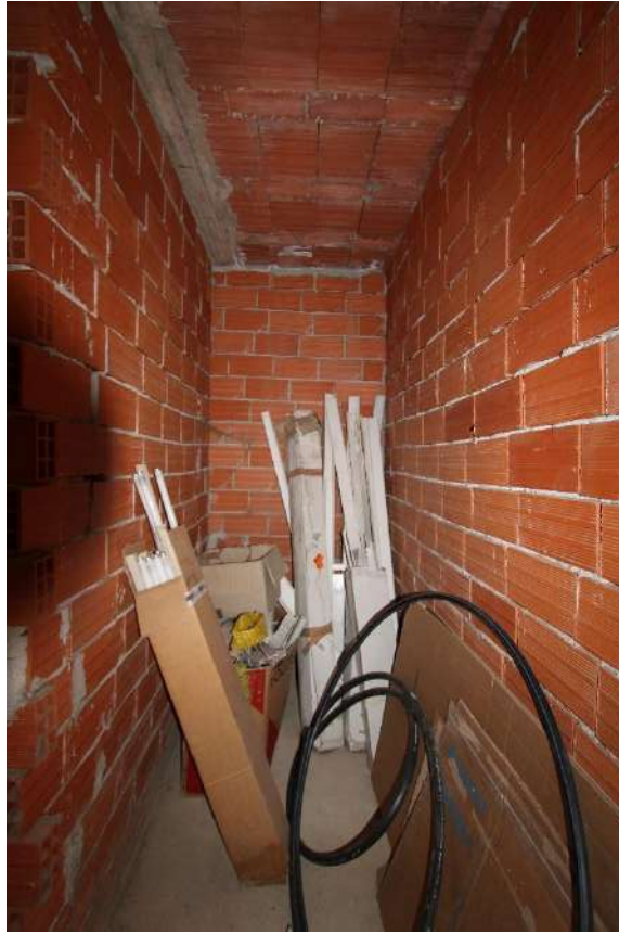
Figura 66- vista 63, corridoio piano terra
