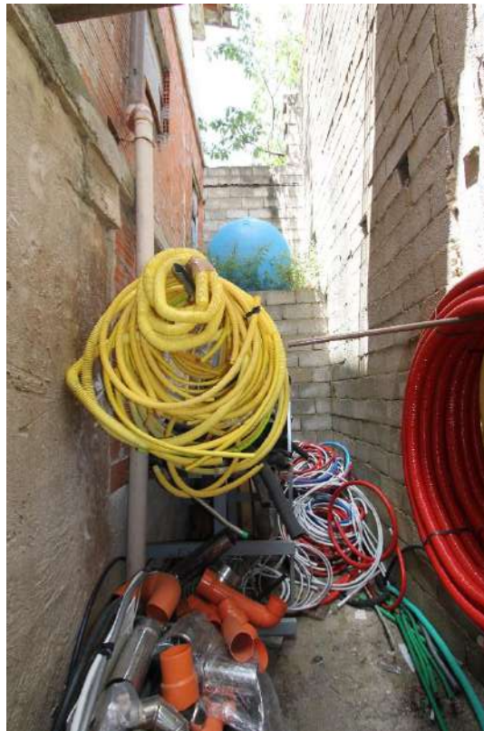
Figura 54- vista 50, Pozzo luce retro Locale magazzino
