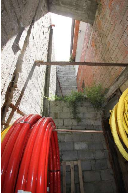
Figura 55- vista 51, Pozzo luce retro Locale magazzino
