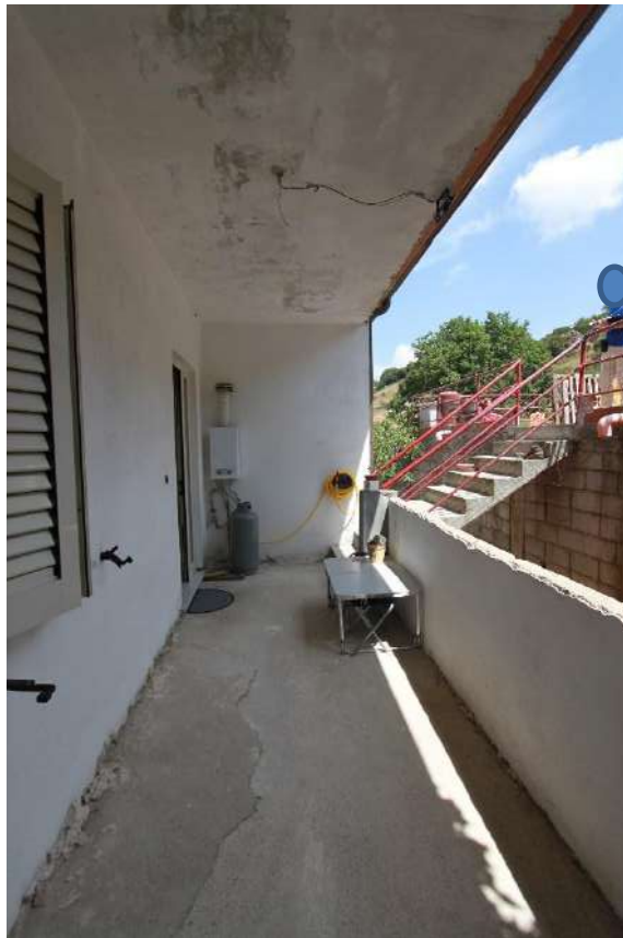
Figura 9584- vista 92, veranda coperta lato Via P. Cossu
