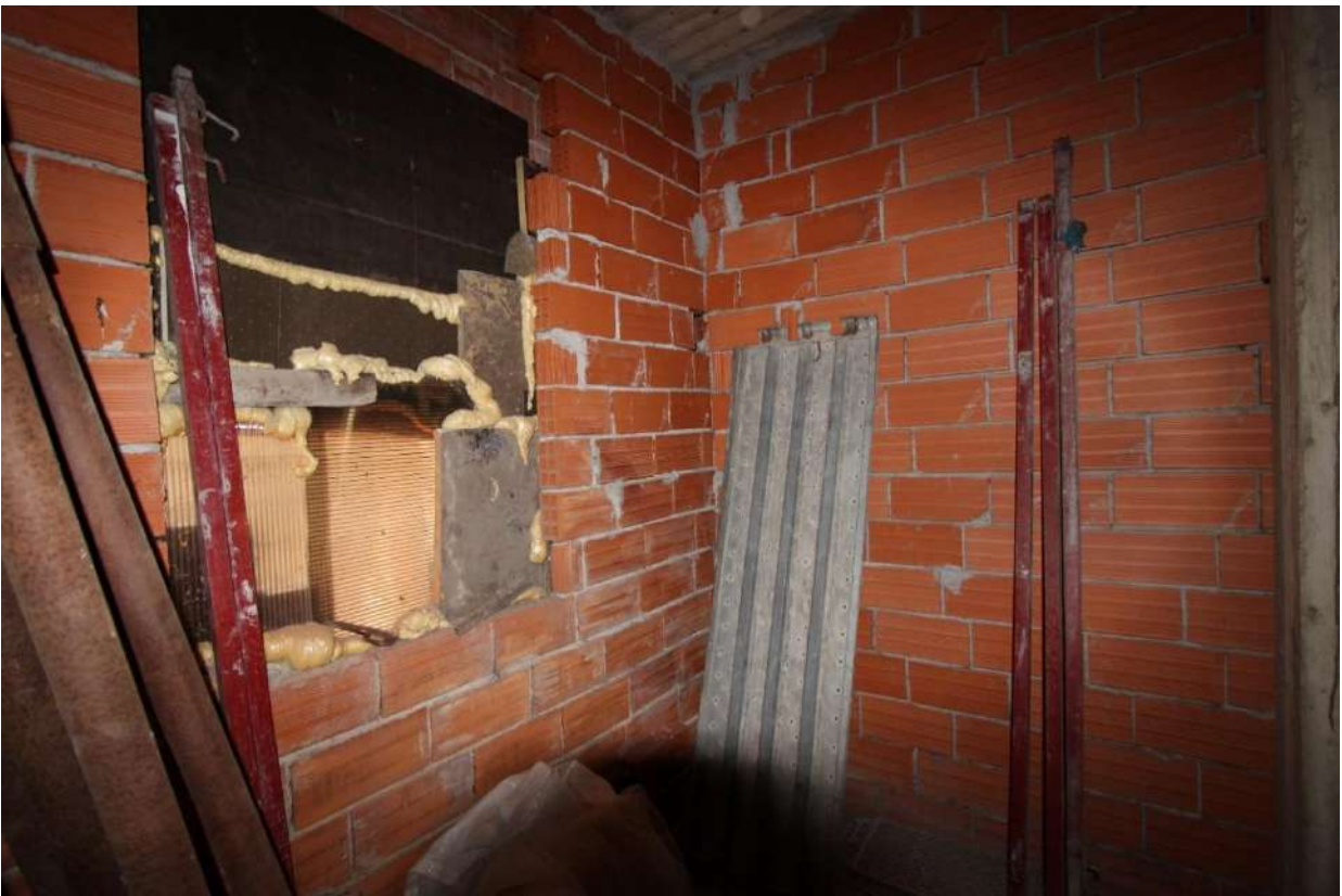
Figura 69- vista 66, camera piano terra
