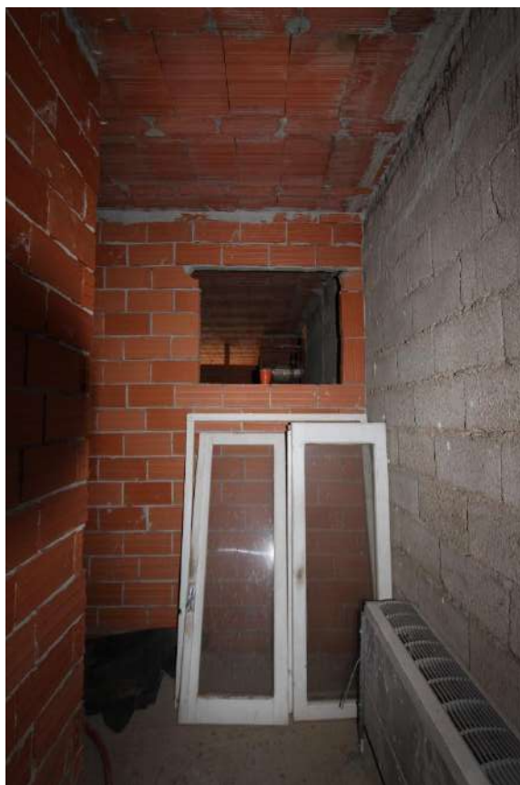
Figura 73- vista 70, camera piano terra
