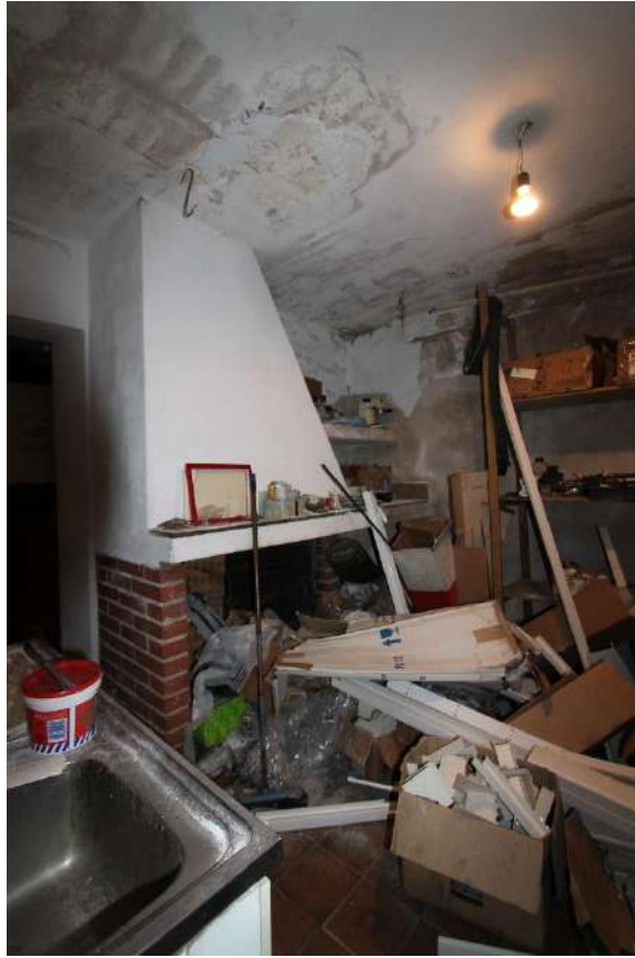
Figura 17- vista 13, loc. deposito
