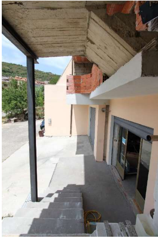
Figura 56- vista 52, piazzale d'ingresso lato Via P.P.Siotto
