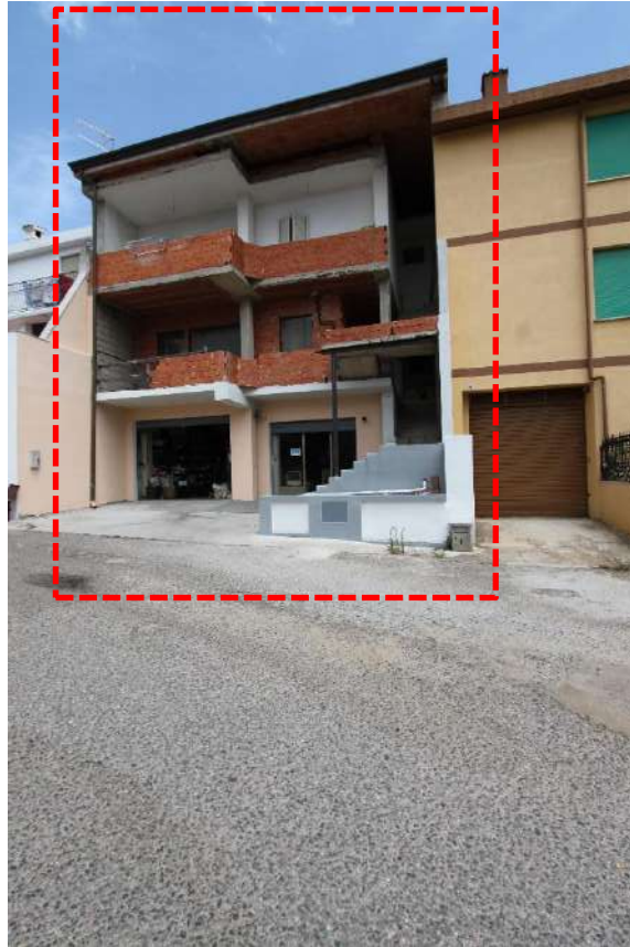
Figura 41- vista 37, Fabbricato dalla Via P.P.Siotto
