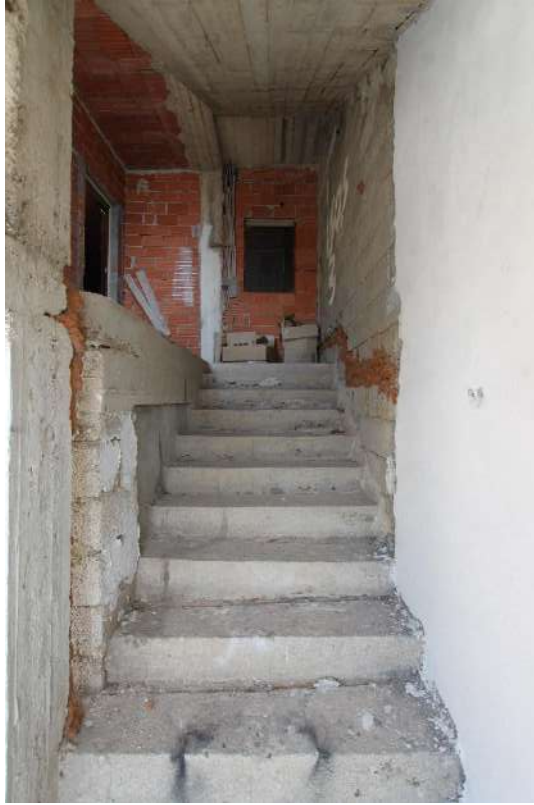
Figura 57- vista 53, Scale esterne di accesso al piano terra e primo
