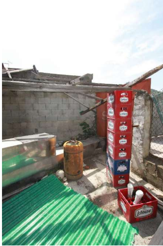
Figura 29- vista 25, manufatti sul mappale 1231
