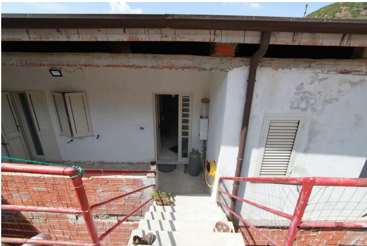
Figura 96- vista 93, veranda coperta con ingresso al primo piano lato Via P. Cossu
