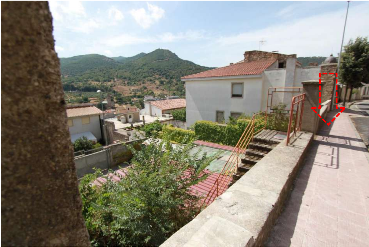
Figura 39_vista 35_Mappale 1324 (marciapiede-porzione strada)
