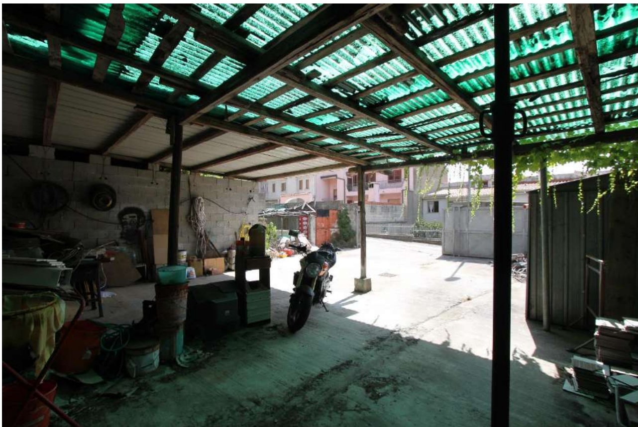
Figura 25- vista 21, Tettoia sui mappali 1231, 1323
