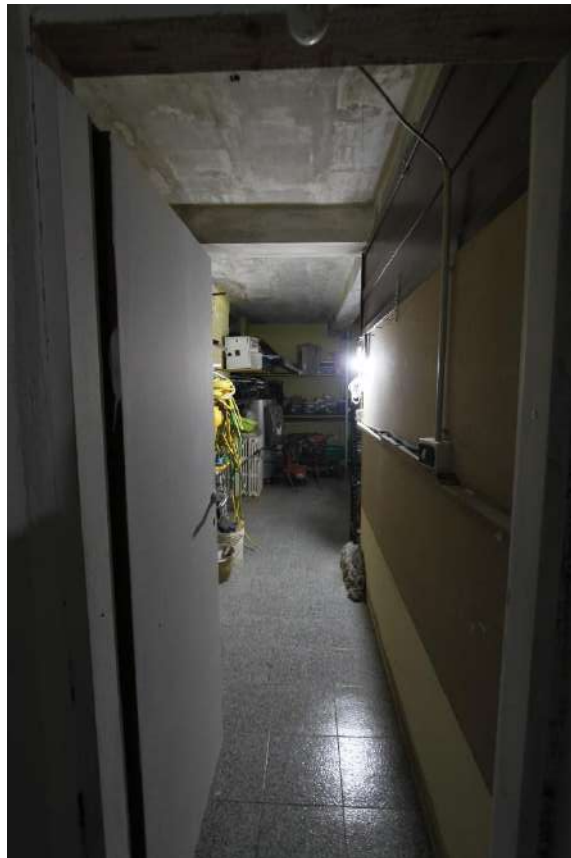
Figura 52- vista 48, Bagno nel Locale magazzino
