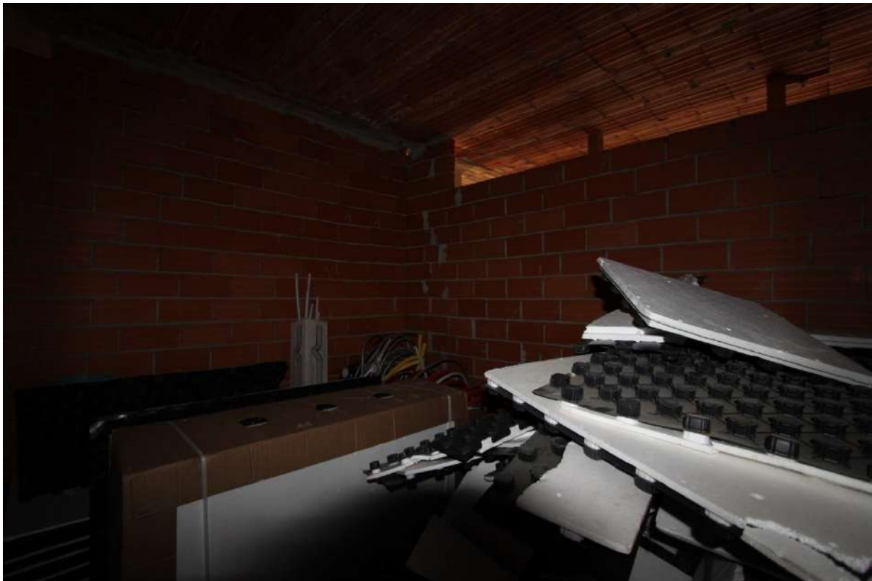
Figura 71- vista 68, camera piano terra
