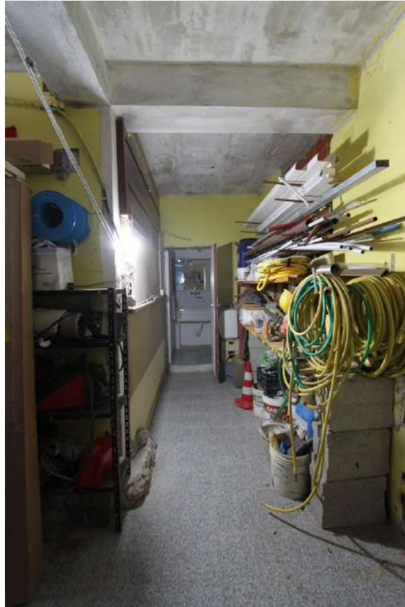
Figura 50- vista 46, Locale magazzino
