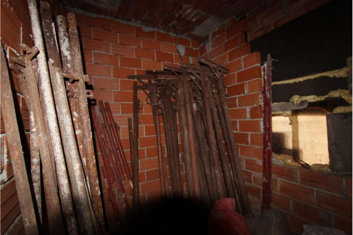
Figura 68- vista 65, camera piano terra
