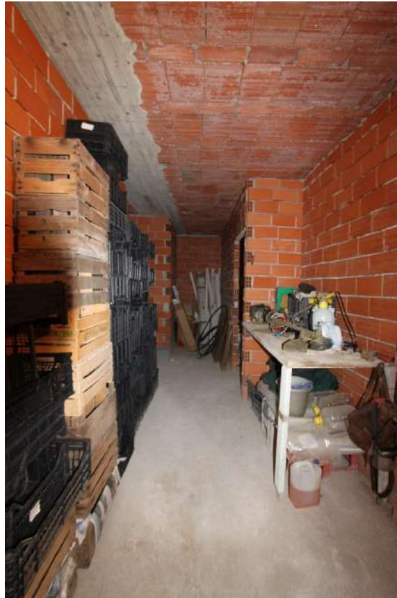
Figura 63- vista 60, camera piano terra
