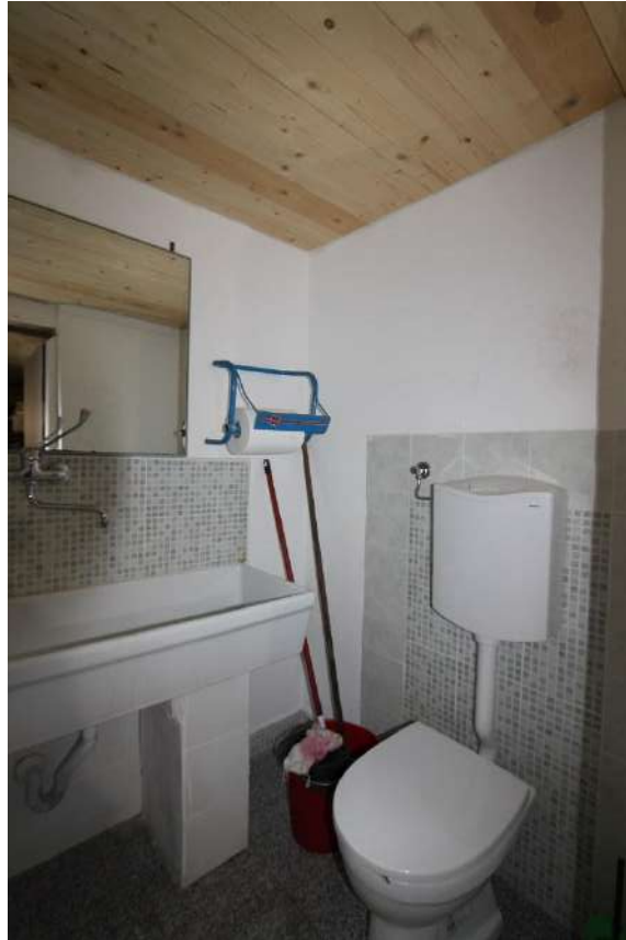
Figura 51- vista 47, Bagno nel Locale magazzino
