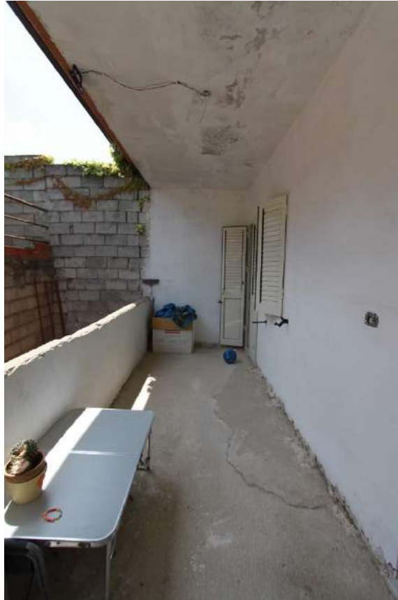
Figura 94- vista 91, veranda coperta lato Via P. Cossu
