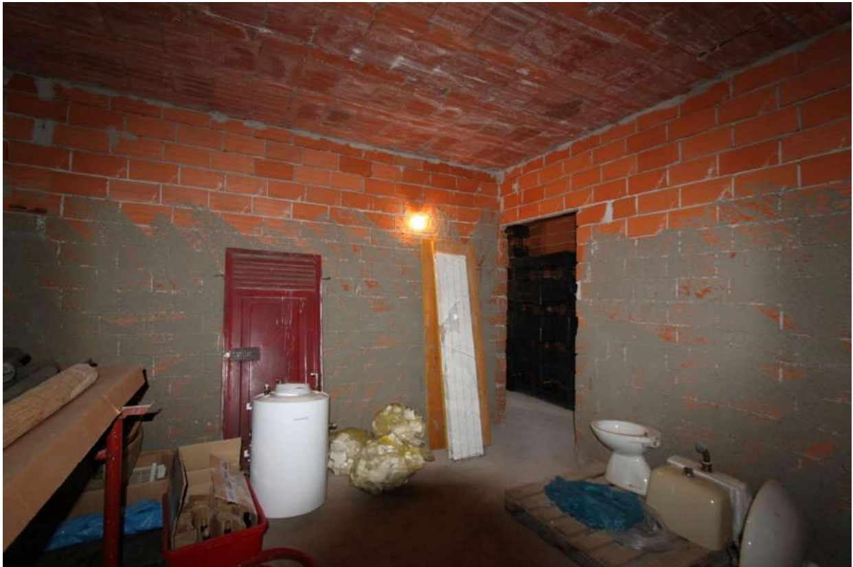
Figura 65- vista 62, camera piano terra
