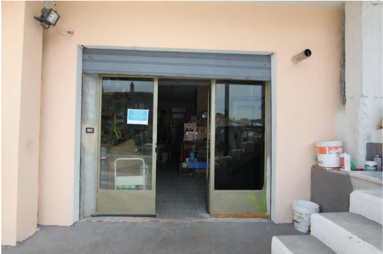
Figura 45- vista 41, Locale magazzino
