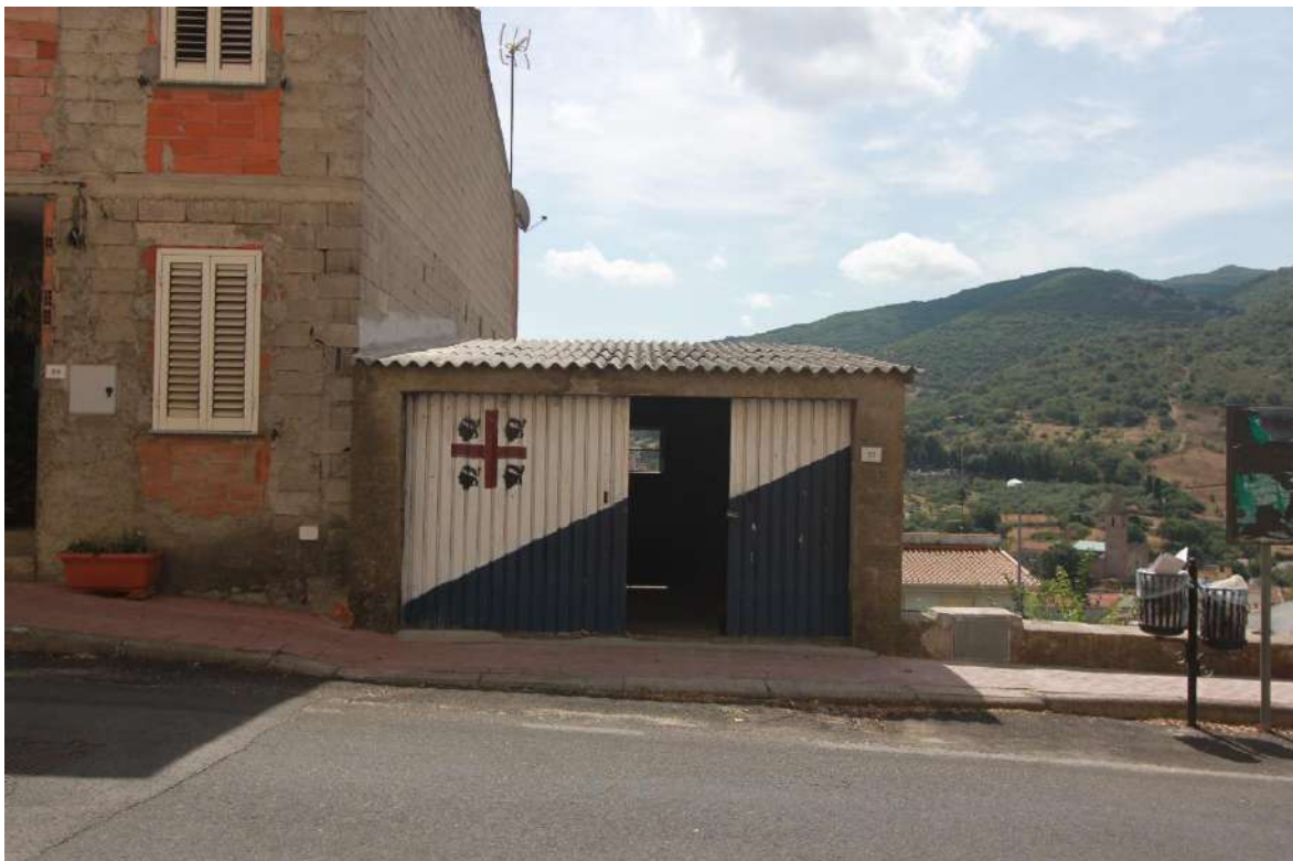
Figura 36- vista 32, garage sul mappale 1231 dalla ss128
