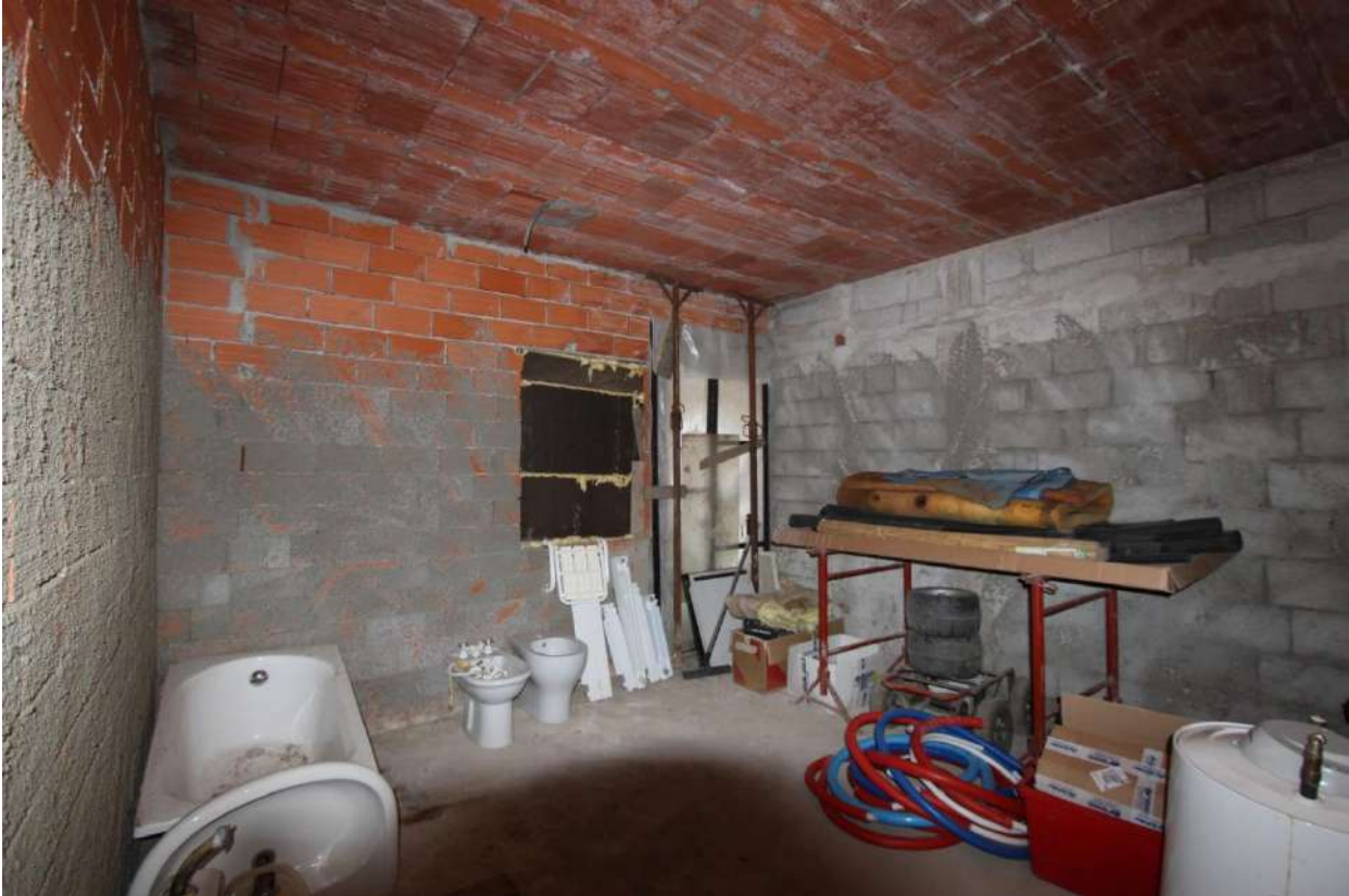
Figura 64- vista 61, camera piano terra
