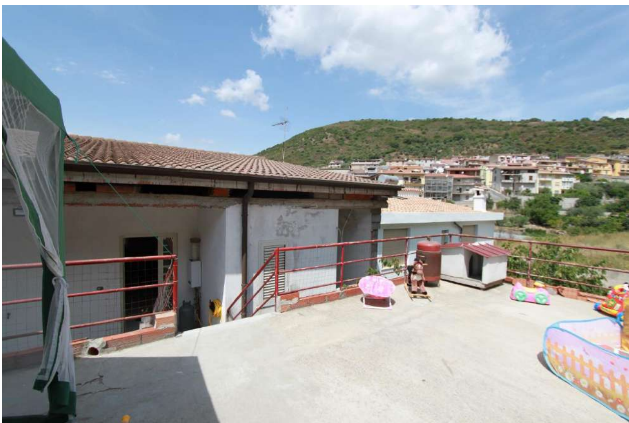
Figura 97- vista 94, cortile con ingresso al primo piano lato Via P. Cossu
