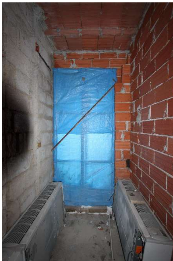
Figura 72- vista 69, camera piano terra
