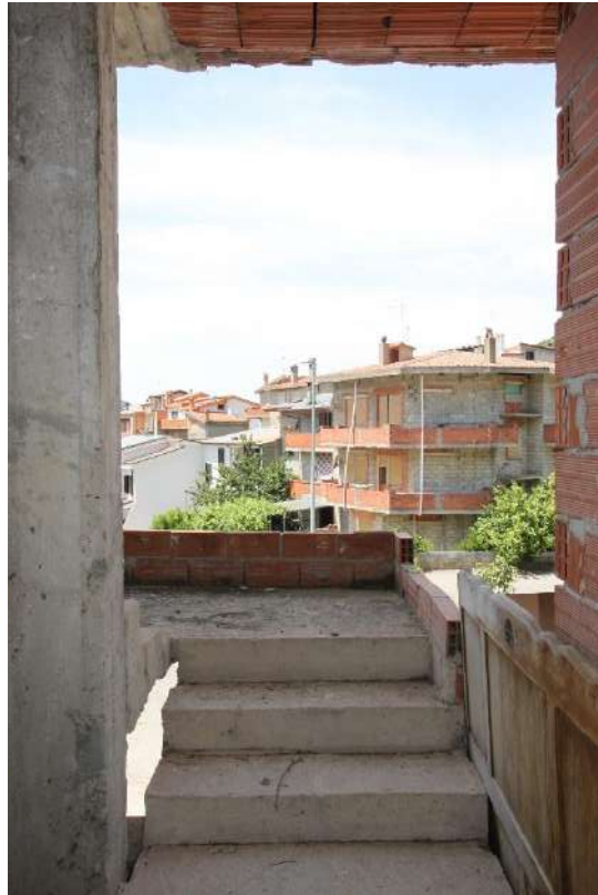
Figura 75- vista 72, scale esterne di accesso al piano primo
