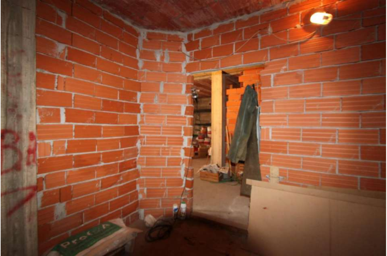
Figura 62- vista 59, camera piano terra
