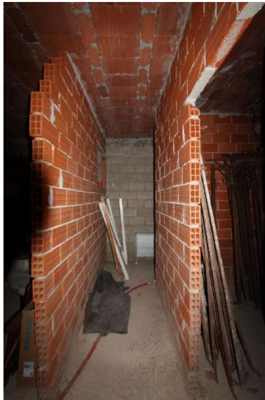
Figura 67- vista 64, corridoio piano terra
