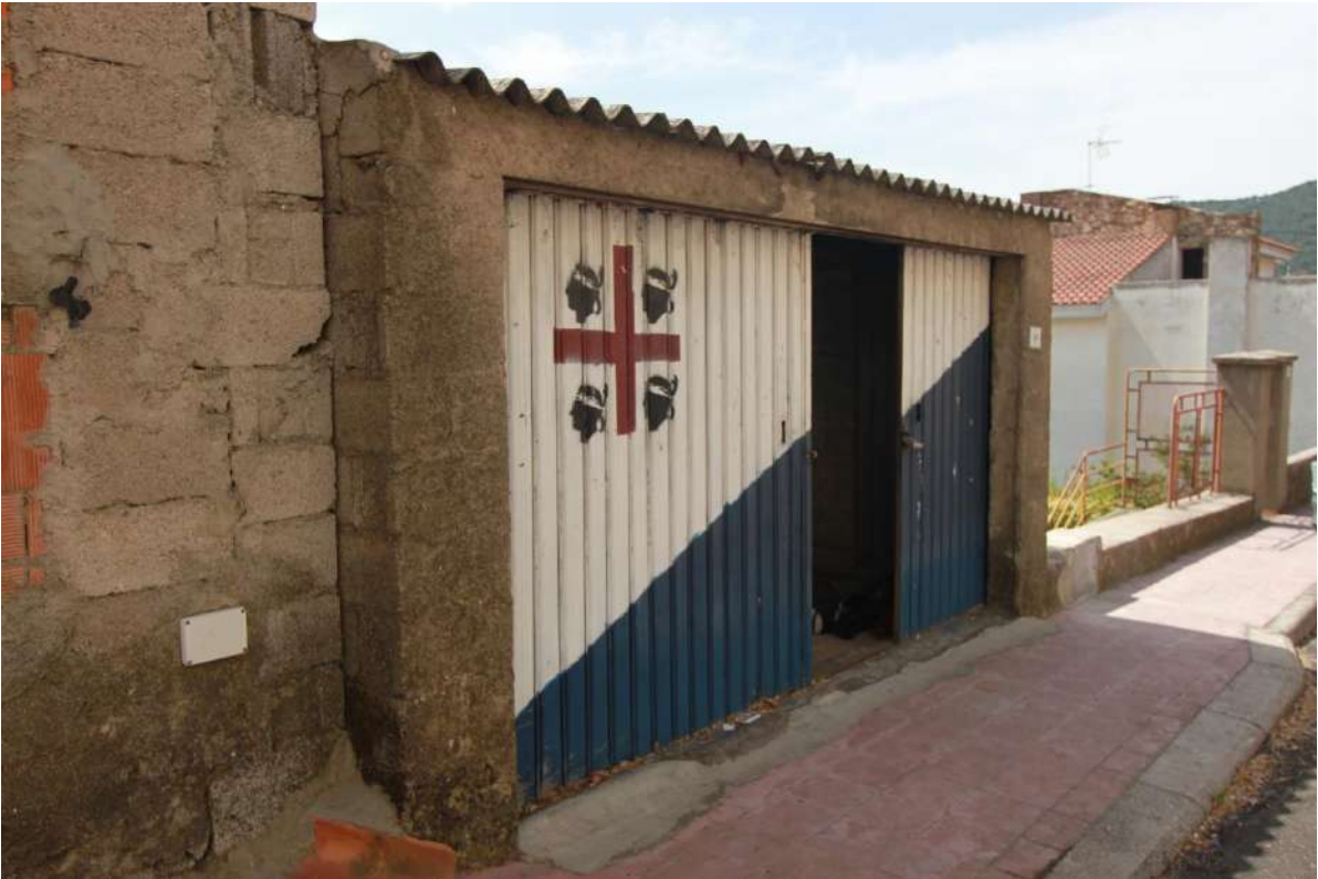
Figura 35- vista 31, garage sul mappale 1231 dalla ss128
