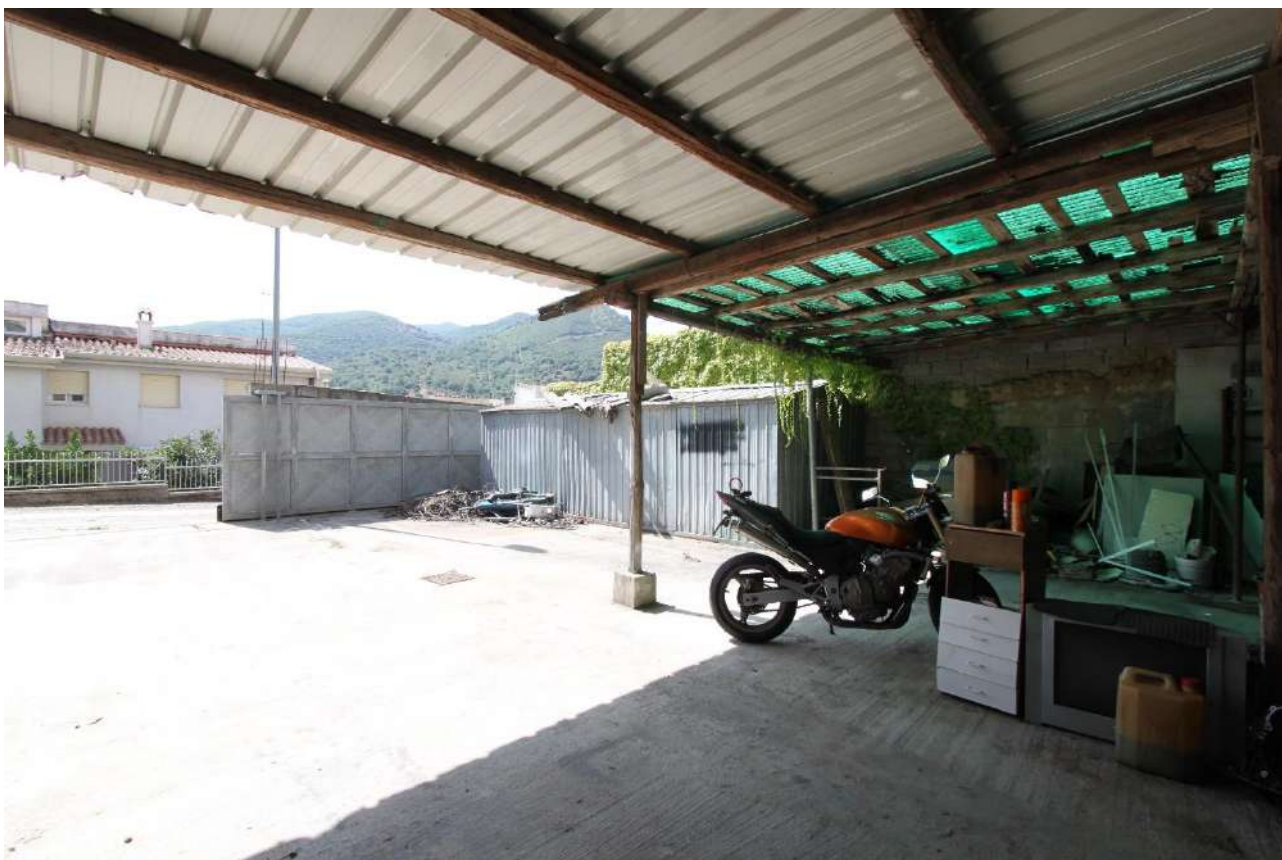
Figura 26- vista 22, Tettoia sui mappali 1231, 1323
