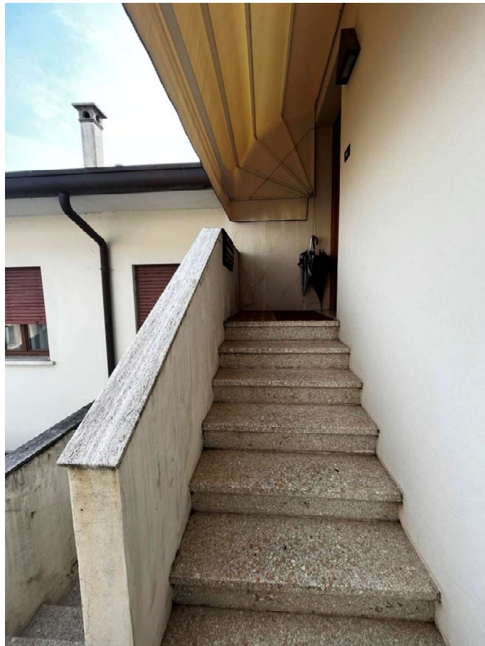
Scala di accesso a piano secondo
