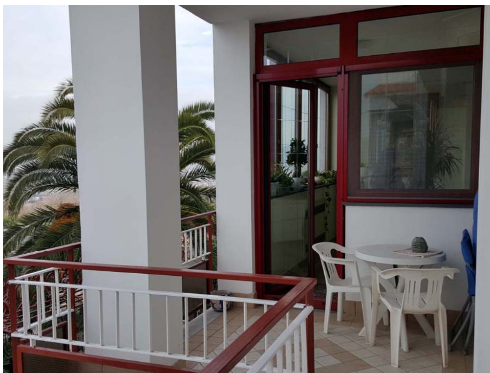
Foto n° 16 - Balcone lato nord
