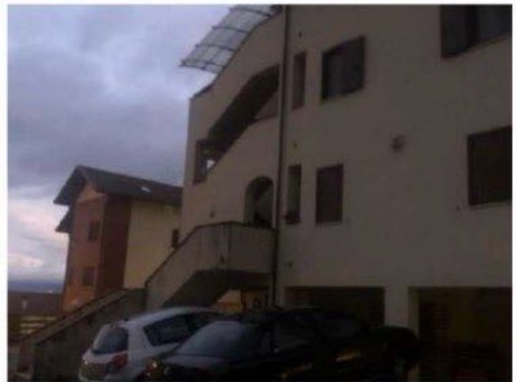
VISTA ESTERNO FABBRICATO
