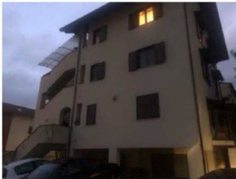
VISTA ESTERNO FABBRICATO
