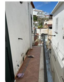
Foto n. 44 - Balcone - unità immobiliare entrando di fronte
