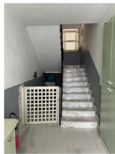
Foto n. 6 – Androne/vano scala del fabbricato
