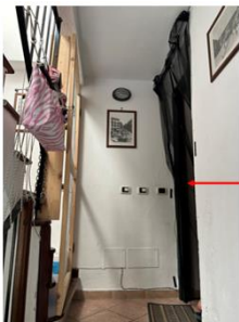
Foto n. 9 - Vano scala del fabbricato - accesso all'immobile pignorato dal vano scala
