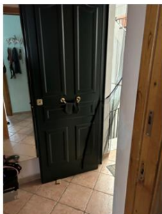
Foto n. 11 - Ingresso dell'immobile pignorato dal vano scala
