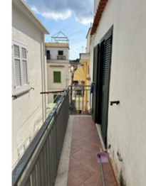
Foto n. 45 - Balcone - unità immobiliare entrando di fronte
