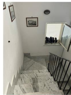
Foto n. 8 – Vano scala del fabbricato
