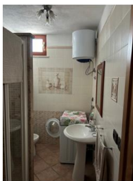
Foto n. 36 - Bagno n.2 - unità immobiliare entrando di fronte
