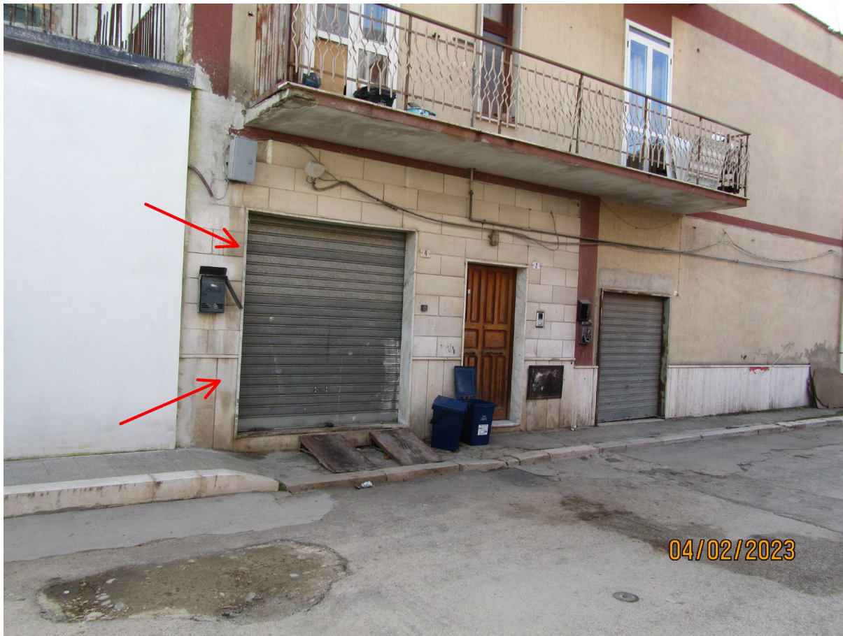
FOTO N. 1 – VEDUTA ESTERNA LOCALE DEPOSITO CIVICO N.4.
