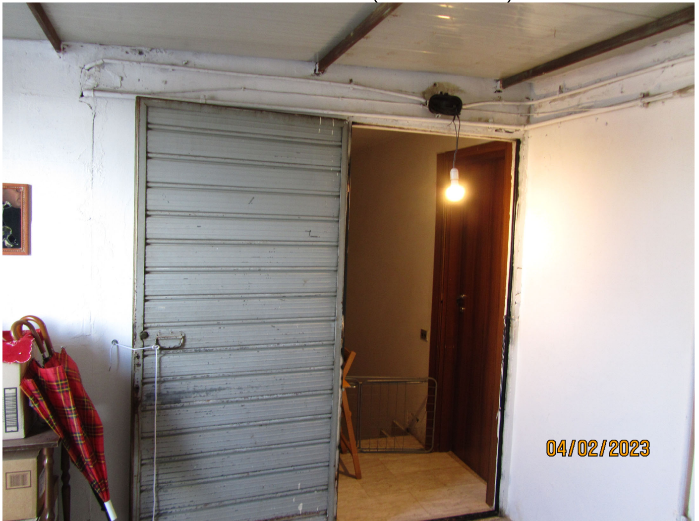
FOTO N. 23 – VANO 2 – PORTA DI ACCESSO (VISTA INTERNA).
