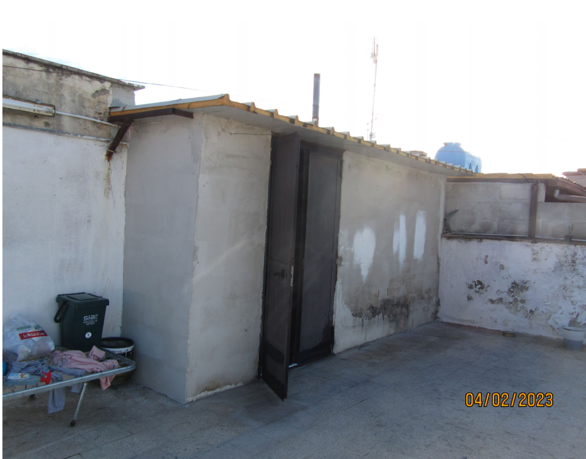
FOTO N. 20 – VISTA ESTERNA DEL VANO 2 – PORTA DI USCITA SUL TERRAZZO.
