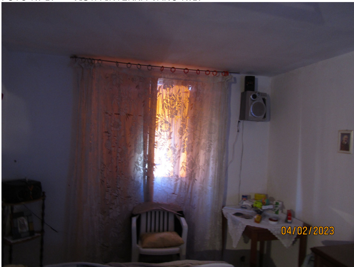
FOTO N. 17 - VISTA INTERNA VANO N.1.
