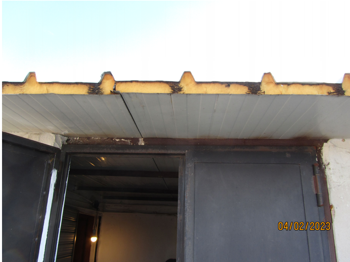
FOTO N. 21 – PARTICOLARE DELLA COPERTURA DEL VANO 2.
