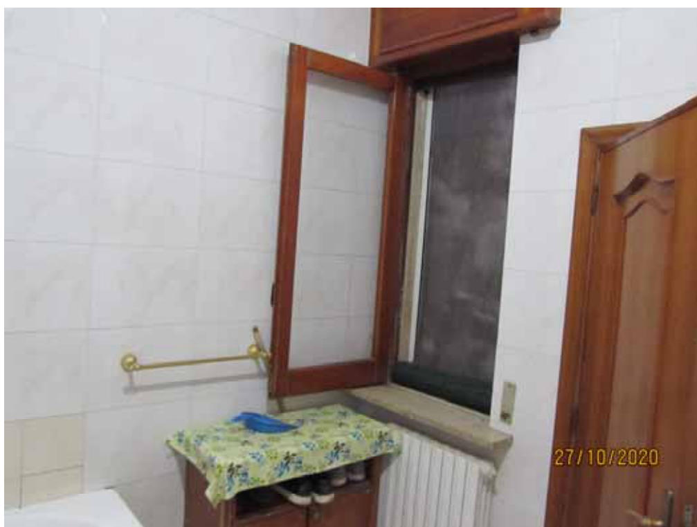
FOTO 10 – Finestra del Bagno con affaccio in pozzo luce.
