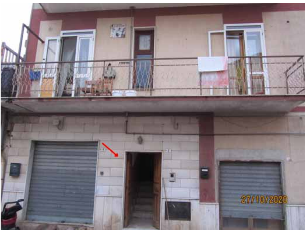
FOTO 2 – Veduta esterna (la freccia in rosso indica il portoncino d'ingresso del civico n.2 di Via S. Michele).
