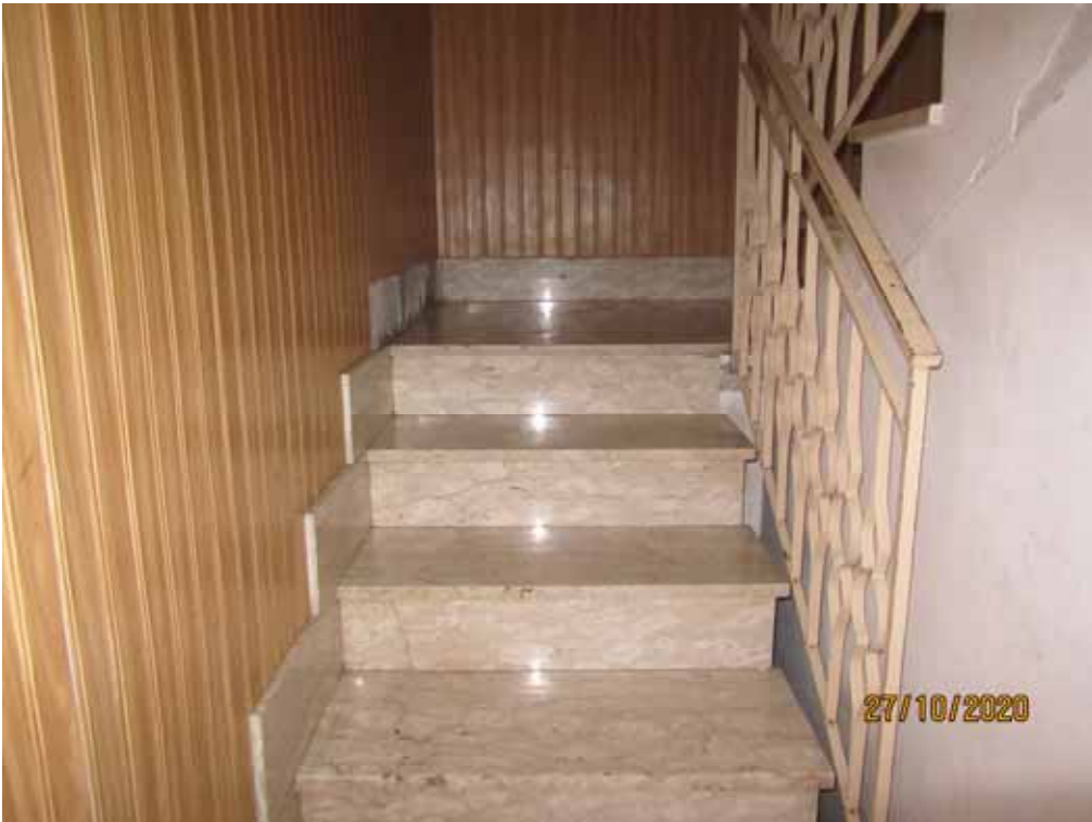
FOTO 4 – Vano scala (1 a rampa).
