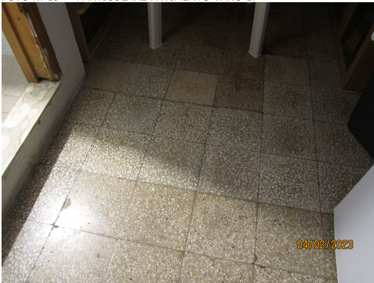
FOTO N. 19 – PARTICOLARE PAVIMENTO VANO 1.
