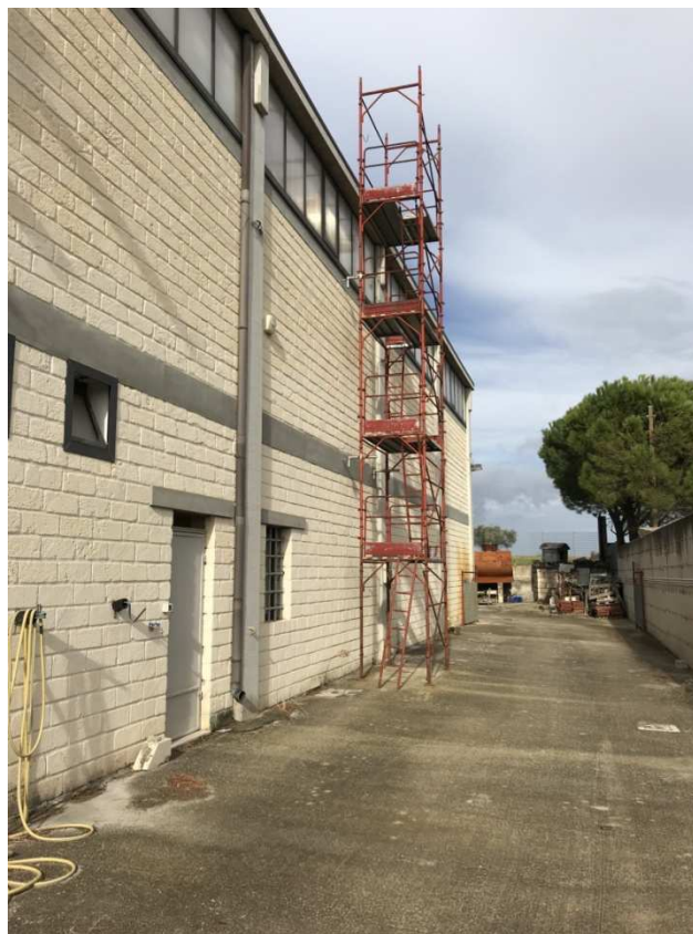
Figura 12 - Area esterna capannone
