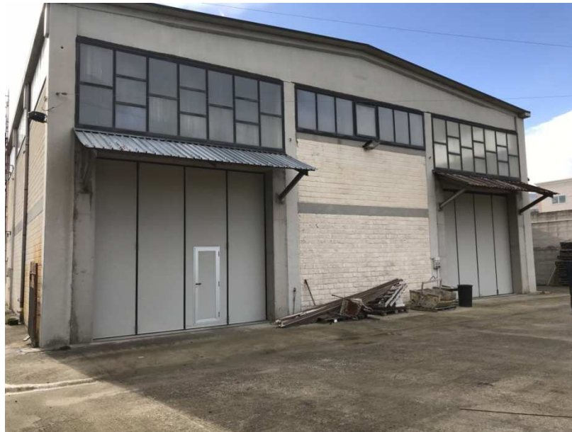
Figura 11 - Area esterna capannone
