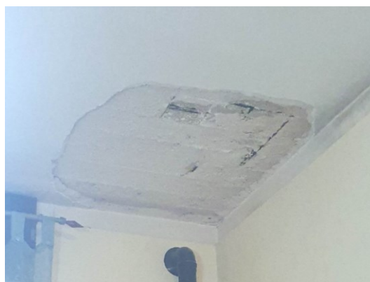
Foto 1-2: Distacco dell'intonaco del soffitto del salone con di fenomeni di sfondellamento.
