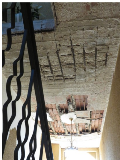
Foto 3-4: Distacchi e fenomeni di sfondellamento precedenti presenti nell'androne e vano scala.
