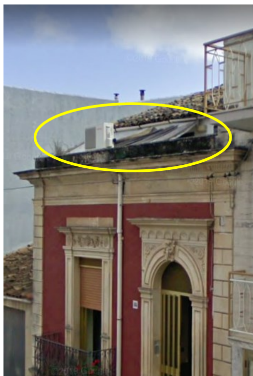
Foto 5: Terrazzino soprastante il salone (evidenziato in giallo)
