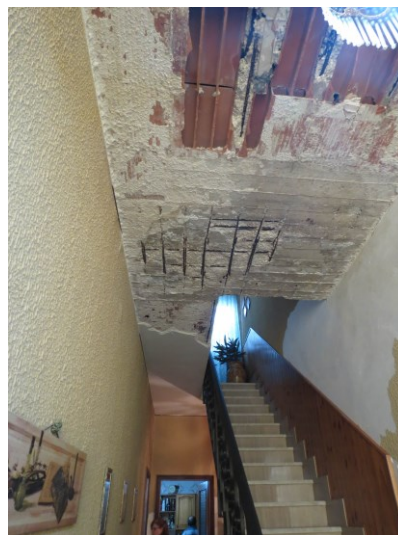
Foto 3-4: Distacchi e fenomeni di sfondellamento precedenti presenti nell'androne e vano scala.
