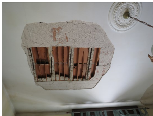
Foto 1-2: Distacco dell'intonaco del soffitto del salone con di fenomeni di sfondellamento.
