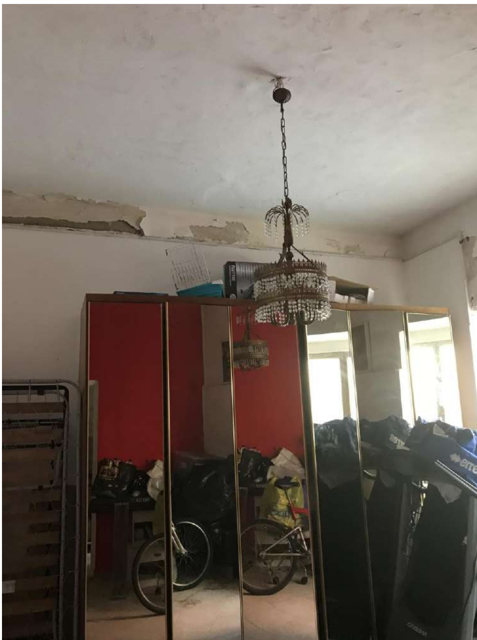
Appartamento piano terra
