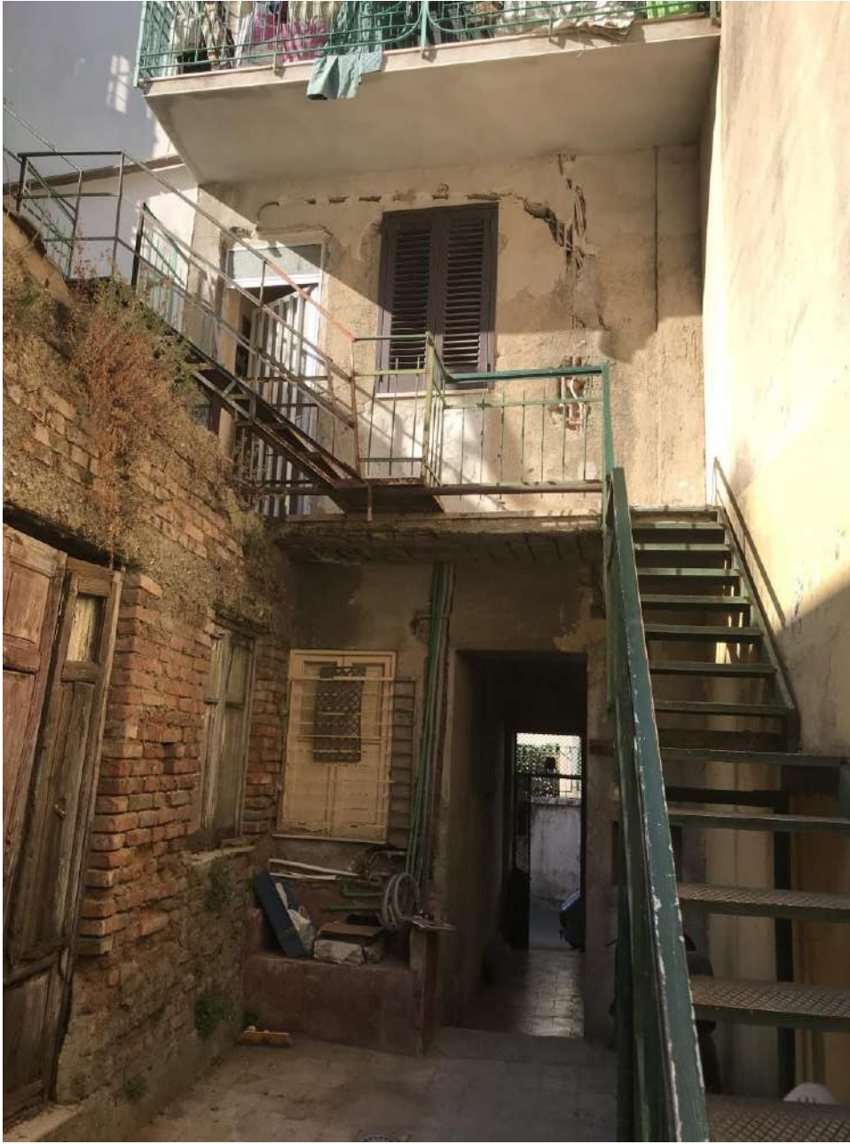
Scala in ferro esterna per accedere all'appartamento al primo piano
