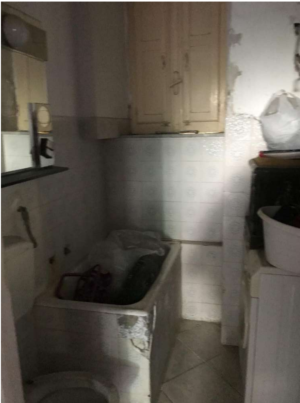
Bagno appartamento piano terra
