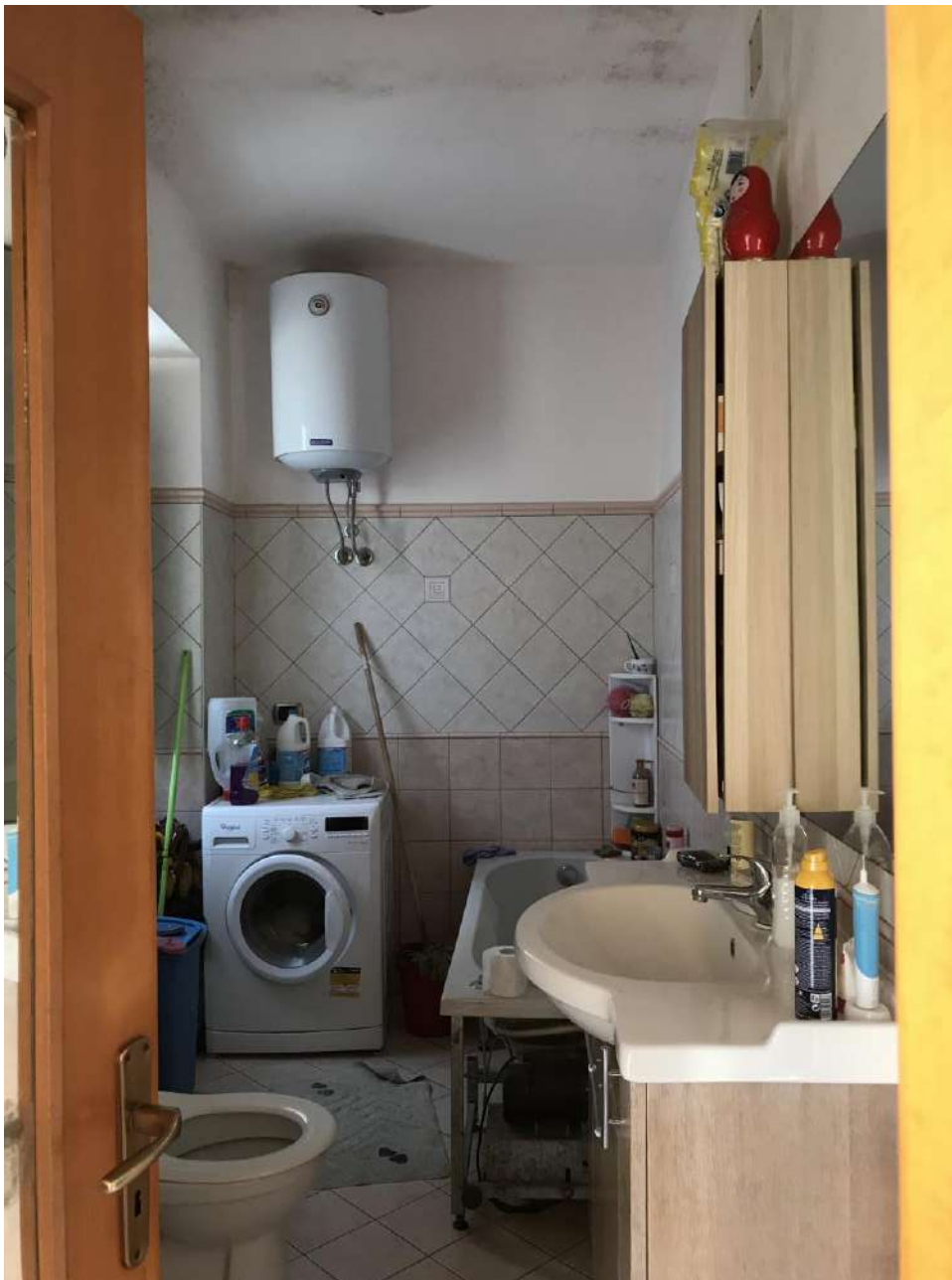
Bagno appartamento primo piano
