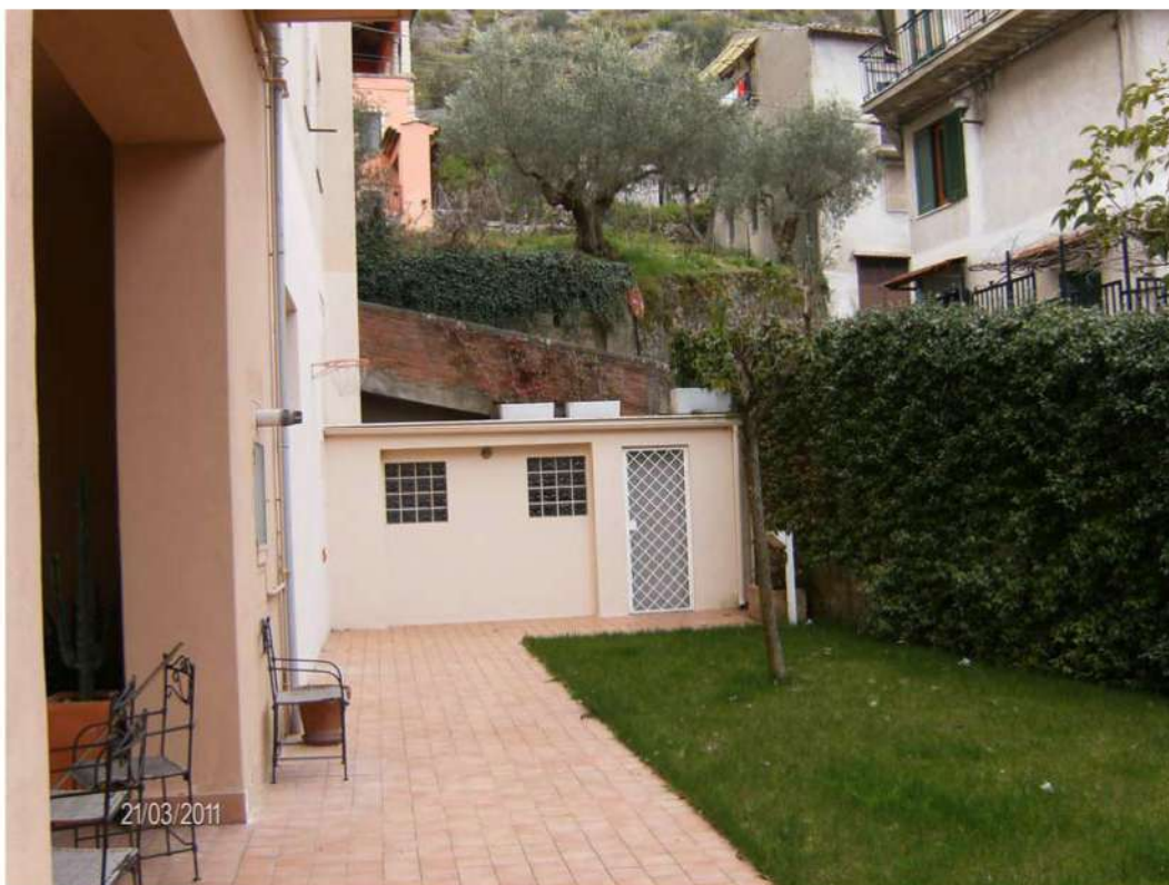
FOTO n. 9 – Corpo esterno sul lato nord, destinato a cucina, non rappresentato nelle planimetrie acquisite
