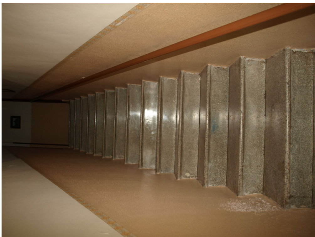
Foto n° 24 – Appartamento in Gela nella via F. Crispi n° 233, primo piano – Foglio 183, part. 973, sub 6 (graffata part. 1485, sub 2) – Panoramica della scala di accesso ai piani superiori.
