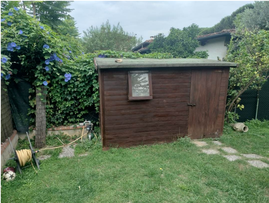
Vista del manufatto in legno realizzato in assenza di titolo edilizio
