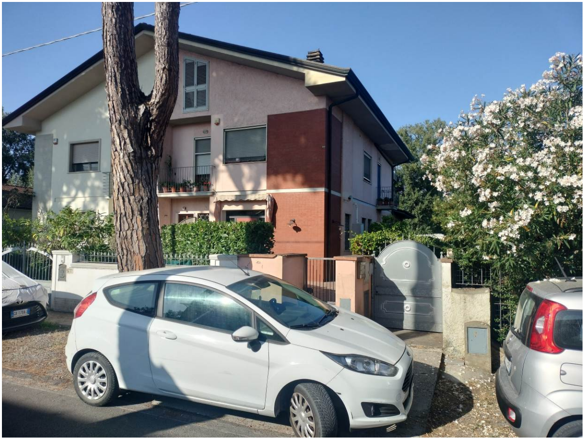
Vista del fabbricato dall'esterno
