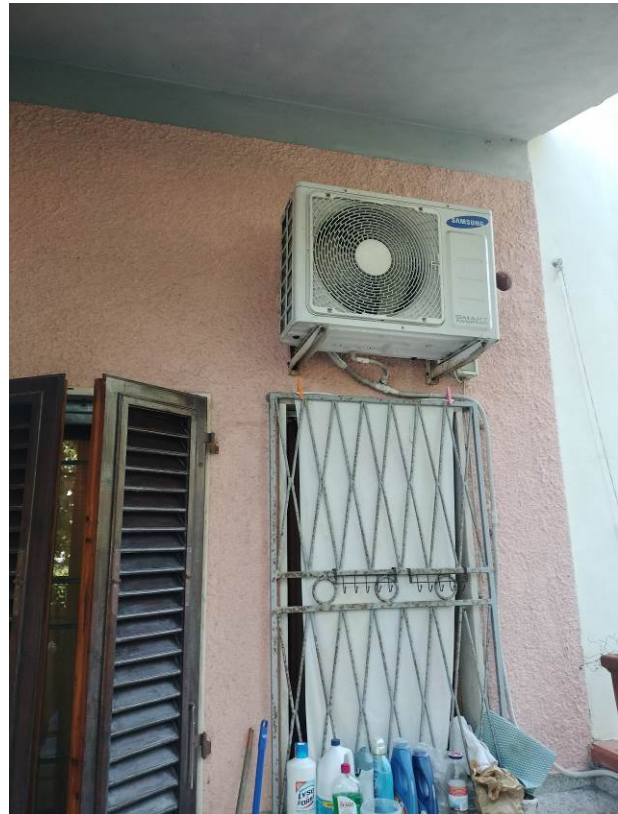
Vista del generatore ACS e della pompa di calore
