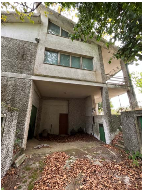
Foto 6 – Vista esterna – Fabbricato
