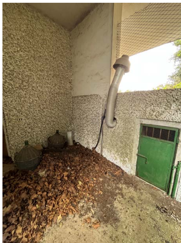
Foto 8 – Vista esterna – Fabbricato
