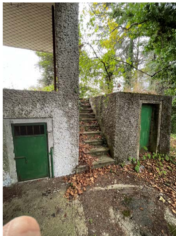
Foto 7 – Vista esterna – Fabbricato
