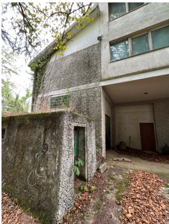
Foto 5 – Vista esterna – Fabbricato
