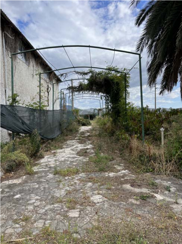
Foto 1 - Vista esterna - viale ingresso
