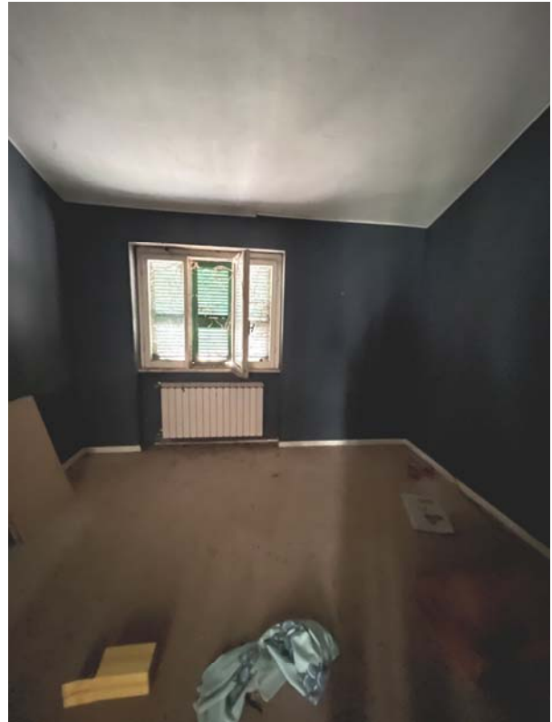
Foto 18 – Vista interna – Camera 3
