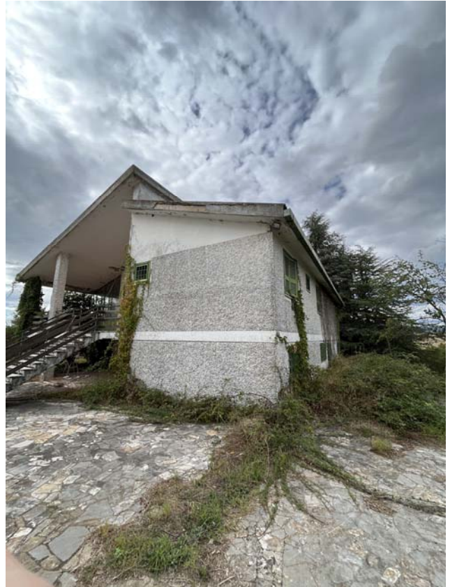
Foto 3 - Vista esterna - Fabbricato
