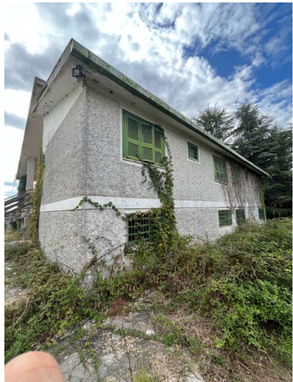
Foto 4 - Vista esterna - Fabbricato
