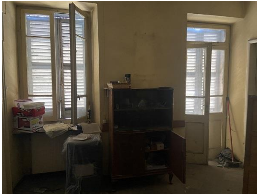
Foto 17: Appartamento –Finestre soggiorno.
