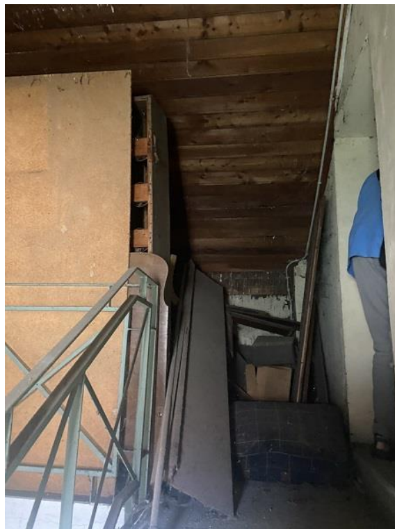
Foto 23: Ingresso alla soffitta condominiale.
