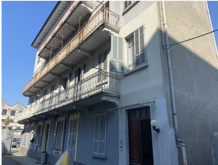
Foto 4: Prospetto sud/est piano terra e primo .
