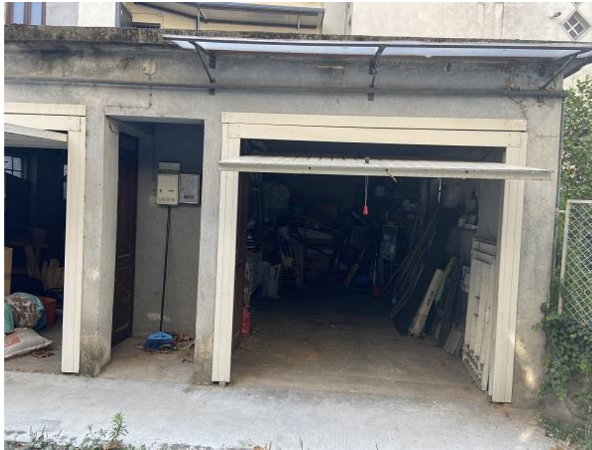
Foto 28: Autorimessa al sub. 3.
