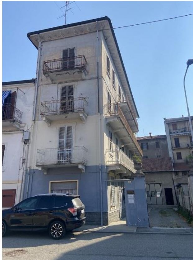
Foto 2: Prospetto ovest su via Spianata Fiera n. 6
