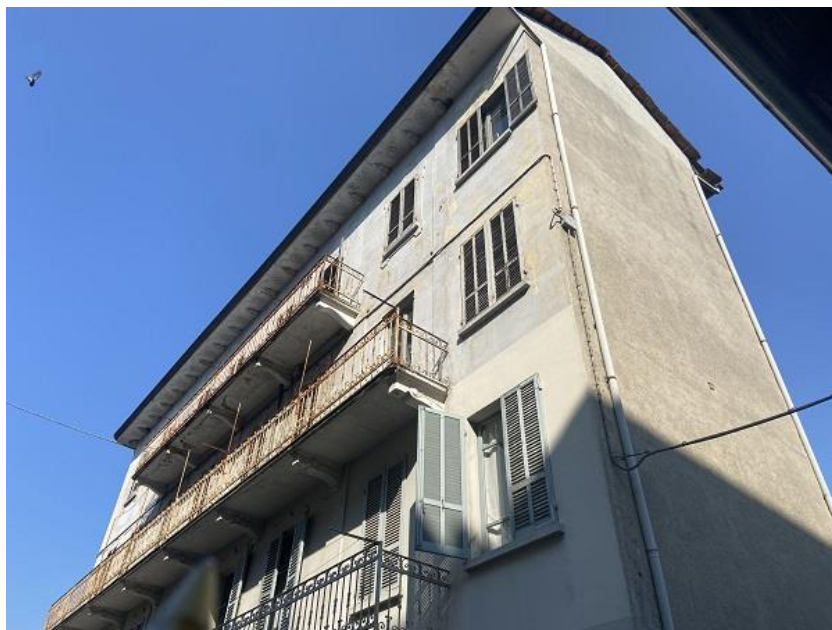
Foto 5: Prospetto sud/est piano secondo e terzo.
