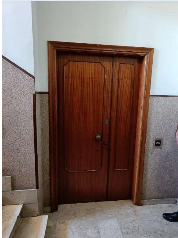
Foto 5. Portone di ingresso all'unità immobiliare
