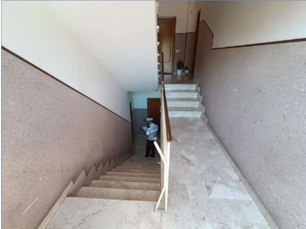
Foto 4. Vano scale condominiale
