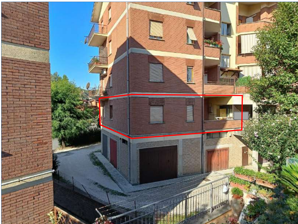
Foto 2. Vista appartamento in oggetto da Viale Giacomo Matteotti
