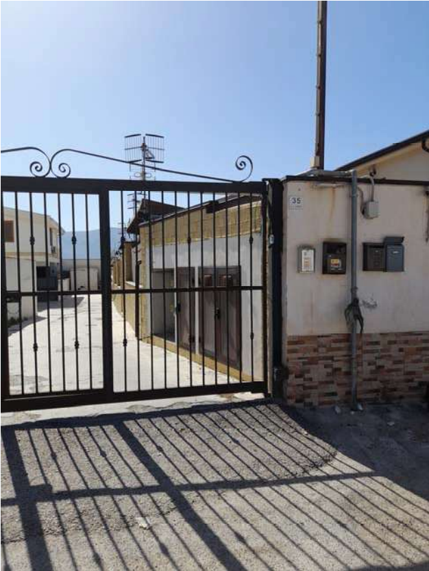
Foto 9 – Ingresso su via Giorgio Almirante n. 35
