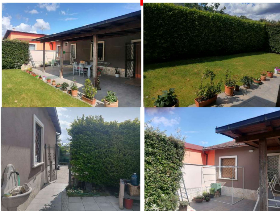
Vista esterna e accesso su Corte interna
