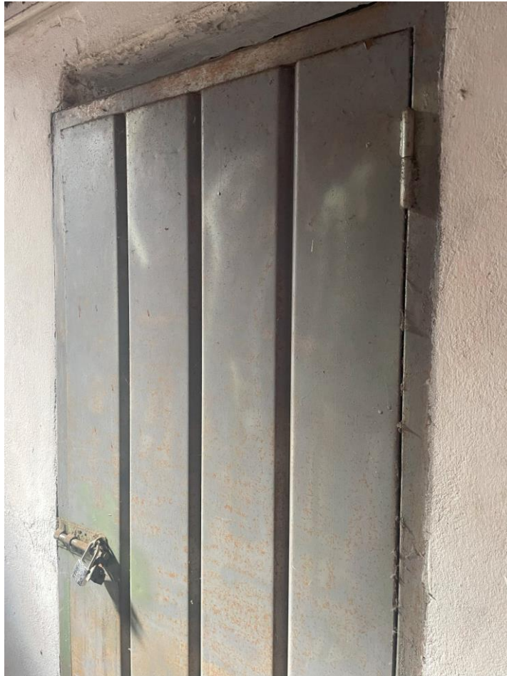
Foto 27. Porta di accesso soffitta n° 21
