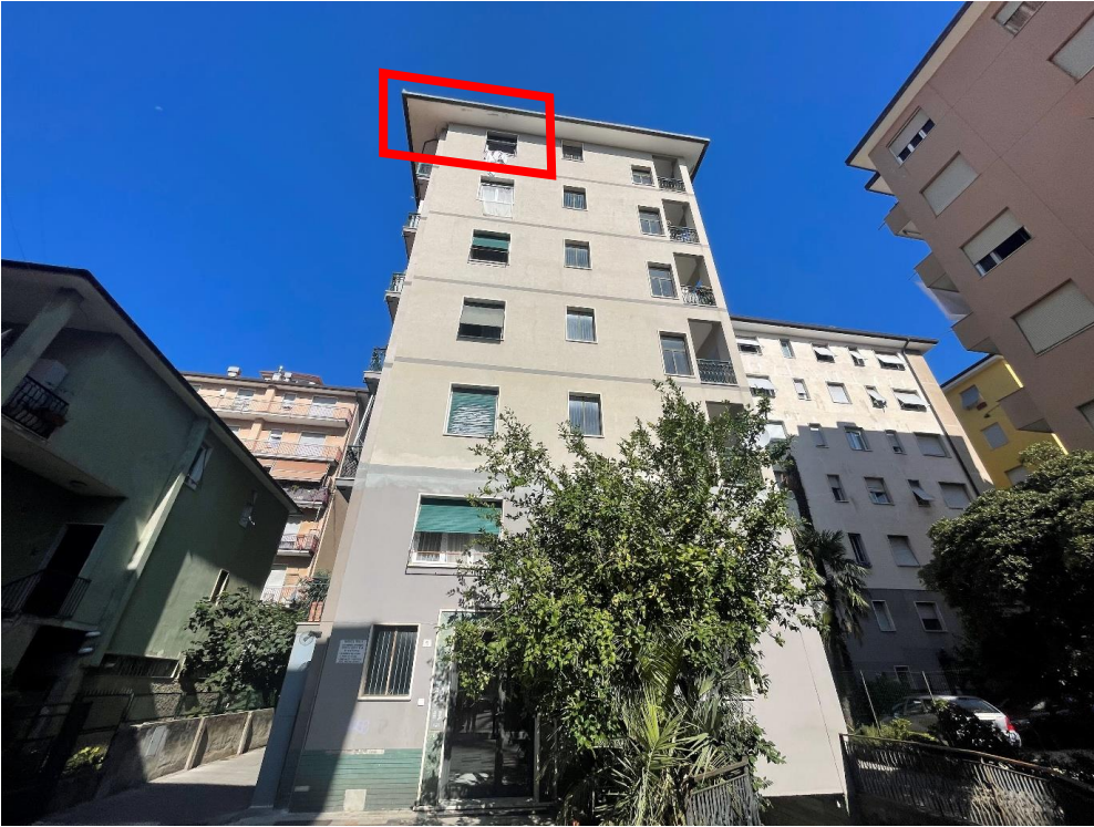
Foto 1. Prospetto sud-est con portone di accesso e localizzazione dell'appartamento
