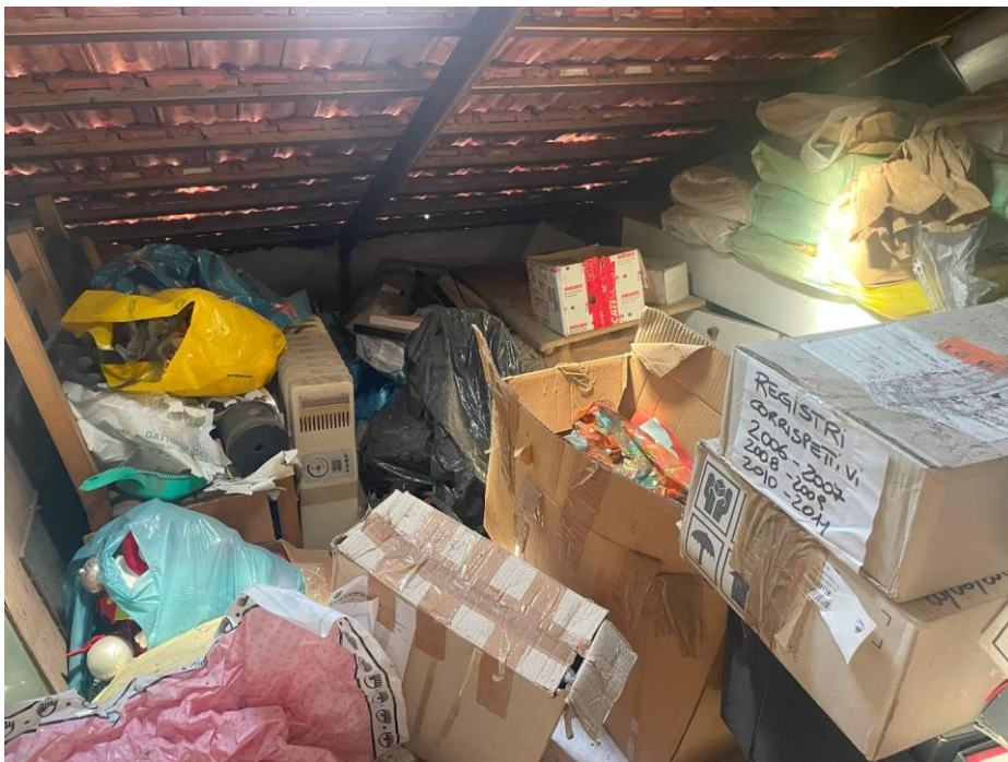
Foto 28. Vista interna locale soffitta n° 21
