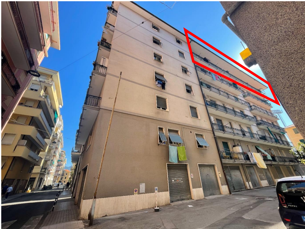
Foto 2. Prospetto sud-ovest con localizzazione dell'appartamento
