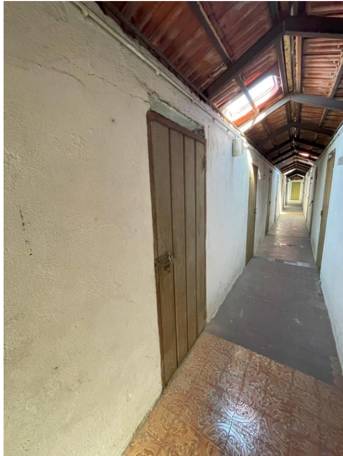
Foto 25. Corridoio di accesso alle soffitte
