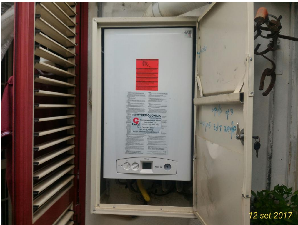
Foto 23: Caldaia a condensazione
