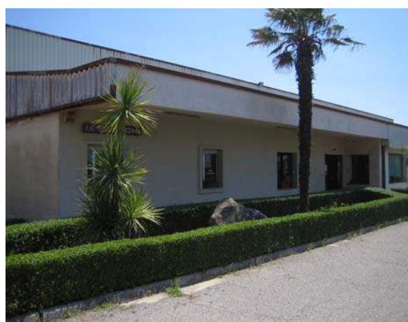
Foto 4, Fabbricato vista frontale - zona esposizione e uffici
