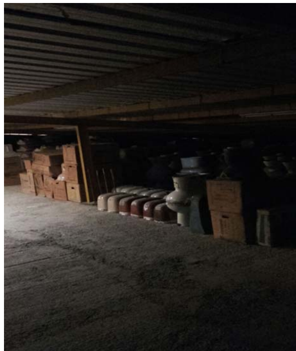
Foto 46 , Vista interna del sottotetto
