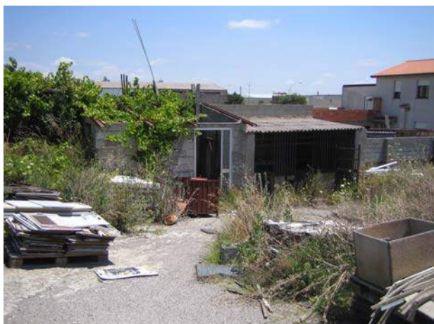
Foto 12 , Baraccamenti esterni in condizioni fatiscenti
