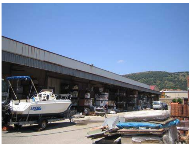
Foto 11 , Vista posteriore fabbricato
