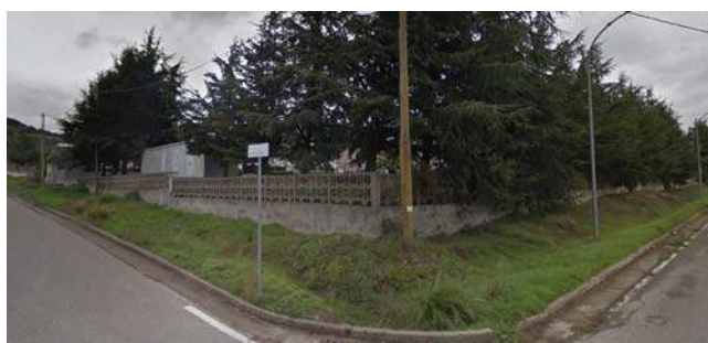
Foto 56 , Vista cabina Enel F34 M.64 SUB 9 - 10
