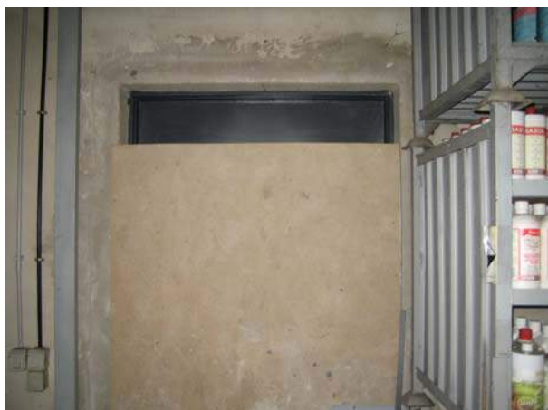
Foto 25 , Chiusura pannello zona in affitto vista interna dal deposito 1
