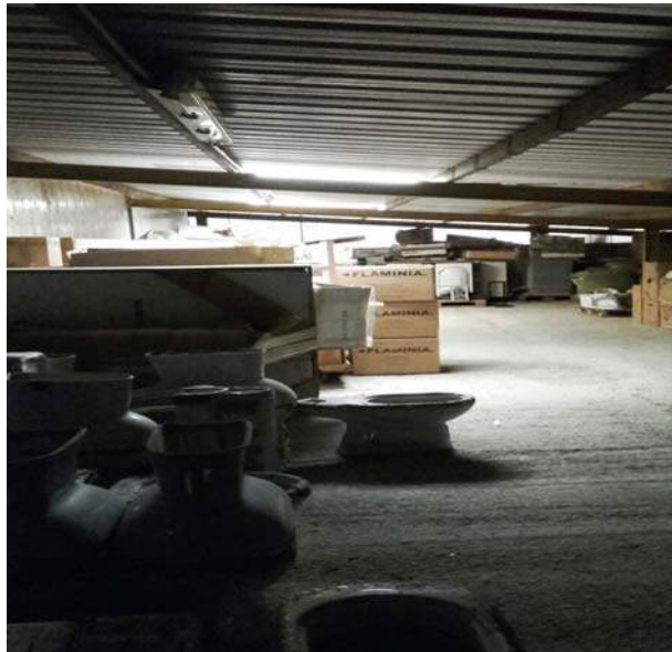
Foto 44 , Vista interna del sottotetto
