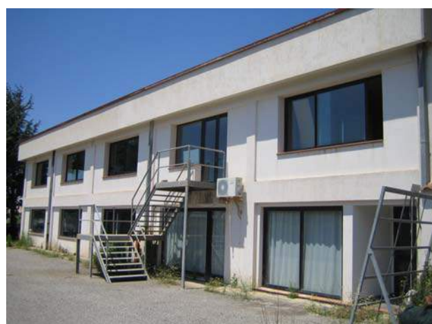
Foto 12 , Vista laterale piano terra piano seminterrato
