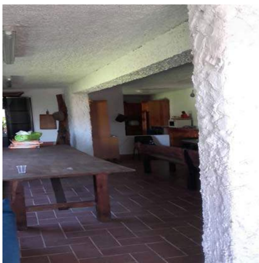
Foto 8 , Deposito 2 materiali allestito a foresteria vista interna
