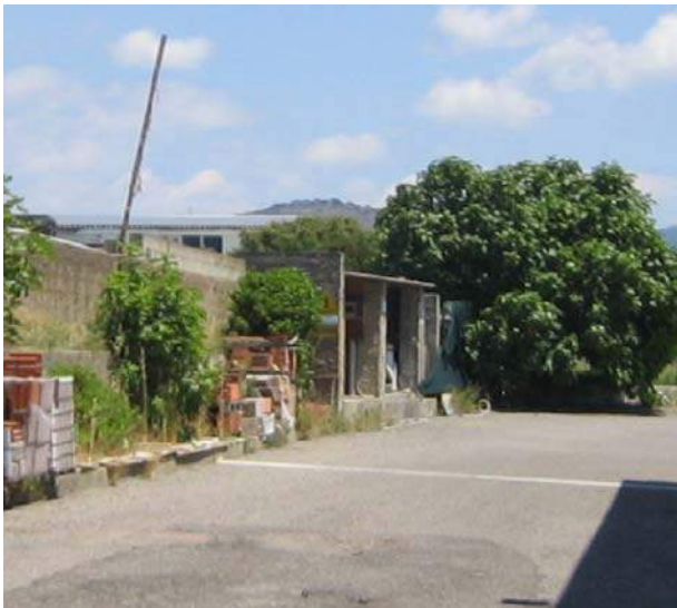
Foto 15 , Baraccamenti esterni in condizioni fatiscenti
