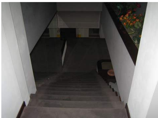
Foto 47 , Scale di accesso Piano seminterrato
