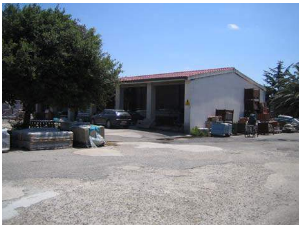
Foto 2 , Deposito 1 materiali e mezzi
