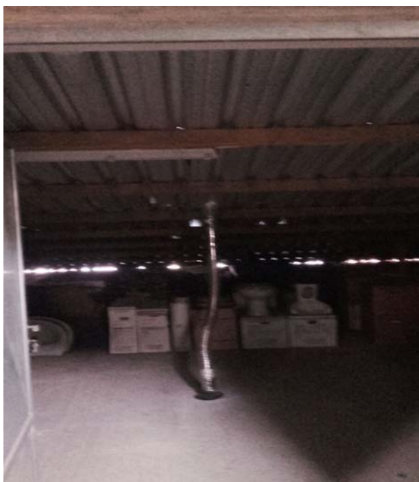
Foto 45 , Vista interna del sottotetto
