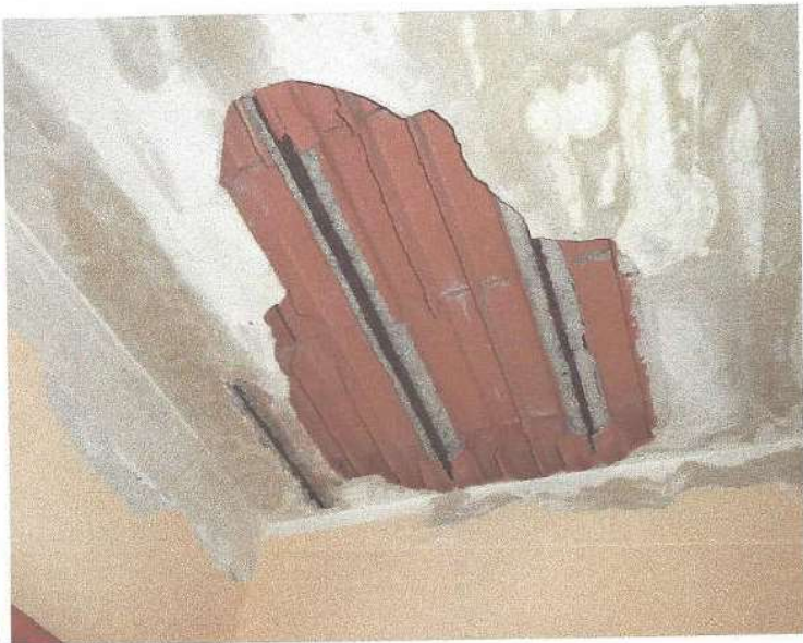
Particolare del soffitto
