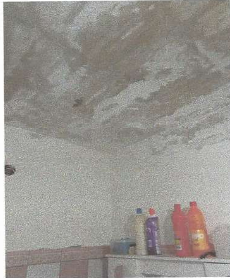
Particolare del soffitto
