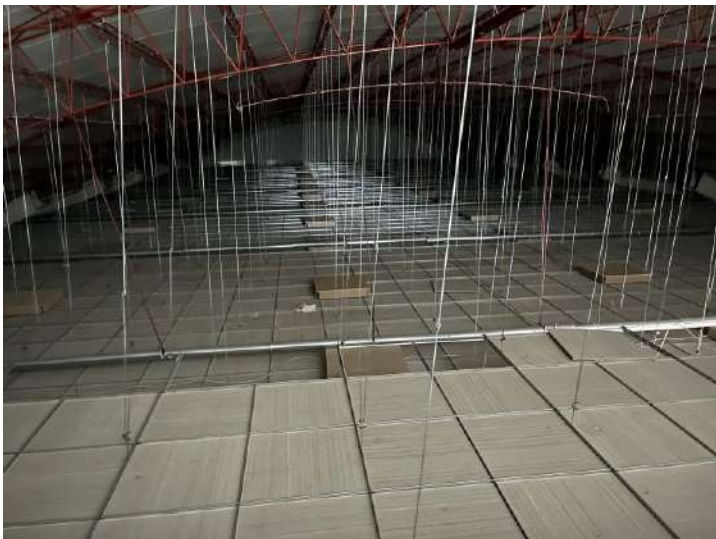
Particolare Copertura a Tetto e controsoffitto del Capannone principale
