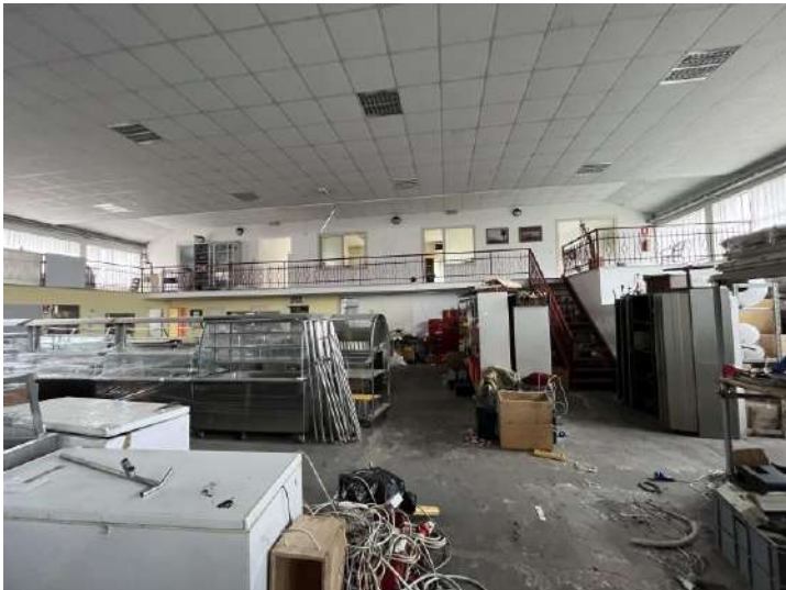
Capannone/Opificio principale (A)
