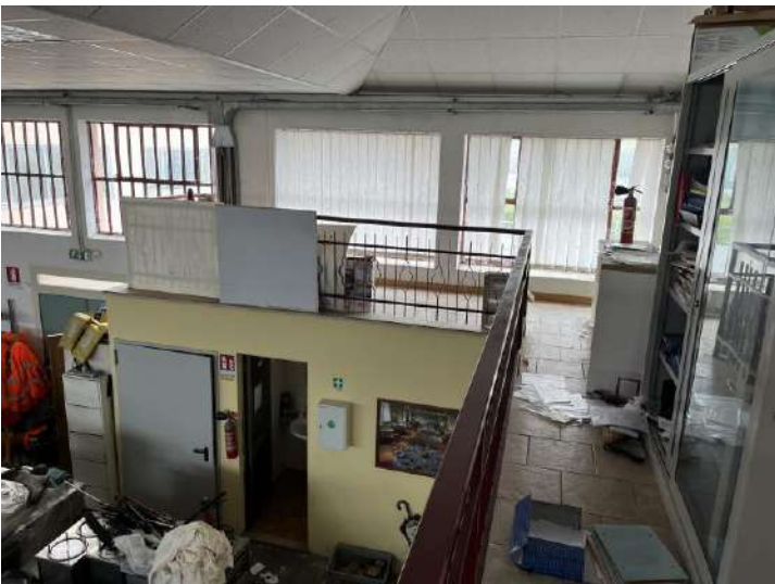
Ballatoio di accesso agli Uffici posti al piano 1°
