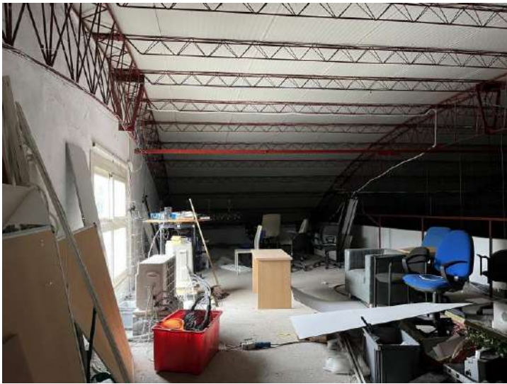
Locale Ripostiglio al piano 2° (F)
